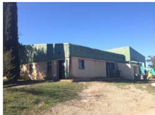
Figure 19 : Bureaux et vestiaire (Source : RA 2014)
