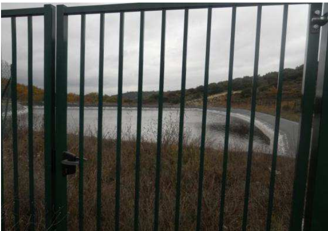
Figure 22 : Bassin de stockage des lixiviats
