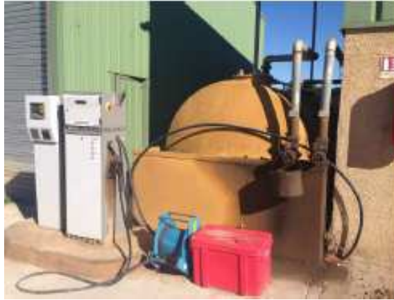
Figure 21 : Cuve à carburant et volucompteur (Source : RA 2014)
