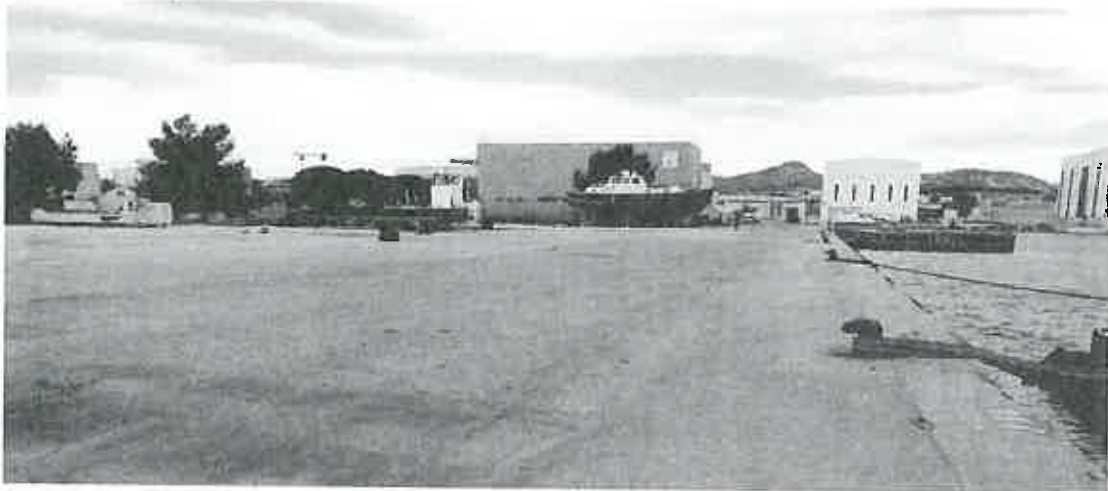
Quai des câbliers dédié au stockage futur des enrochements.
