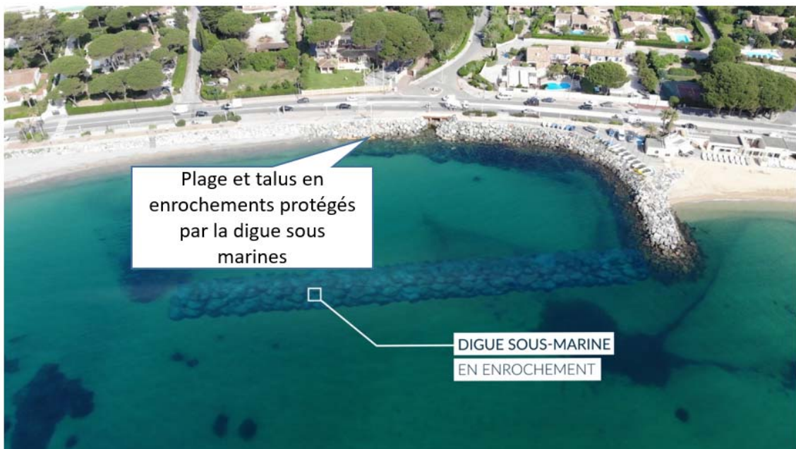
Figure 2 : Digue sous-marines en enrochements au nord de la plage de la Croisette (Extrait vidéomontage Aéronauticfilmmaker – 2018)
