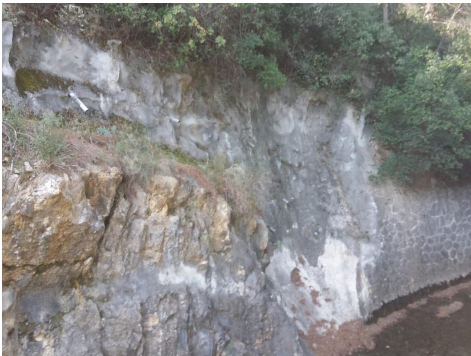
Confortement des parois rocheuses du chenal existant par du béton projeté.
