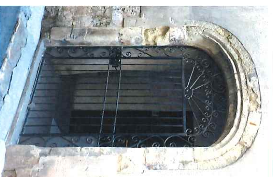
Vantail en feronnerie insérée dans une baie de passage Renaissance.
