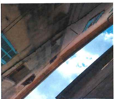
Système mixte : génoise et corniche à denticules
