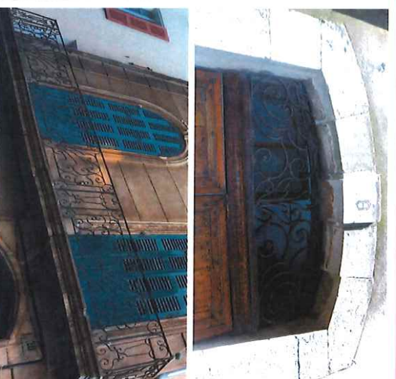
Grille d'imposte XVIIIe s. à motif de palmette (Régence). Balcon en fer forgé à panneaux époque baroque - XVIIIe
