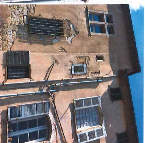
A gauche : baie début XVIIe. A droite : baies XVIIIe à petits carreaux sur travée supérieure et châssis modifié à grandes glaces sur baie inférieure.
