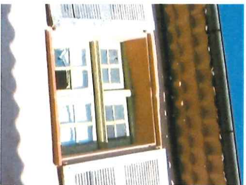
Deux exemples de châssis bois à travers et meneau bois du XVIIIe s.
