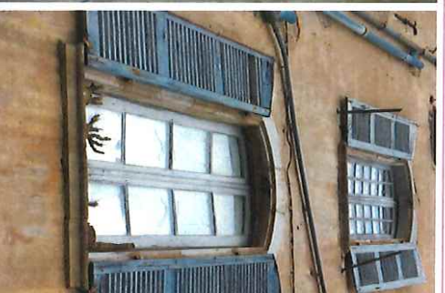
Elevation XVIIIe s. associant châssis à la française à petits carreaux et châssis remanié au XIXe par suppression partielle des petits bois.
