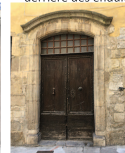
Cintrées ou droites, les portes sont soulignées par un encadrement en pierre généralement assez raffiné (mouluré)
