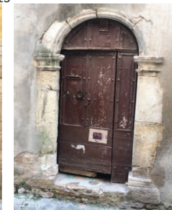
Cintrées ou droites, les portes sont soulignées par un encadrement en pierre généralement assez raffiné (mouluré)
