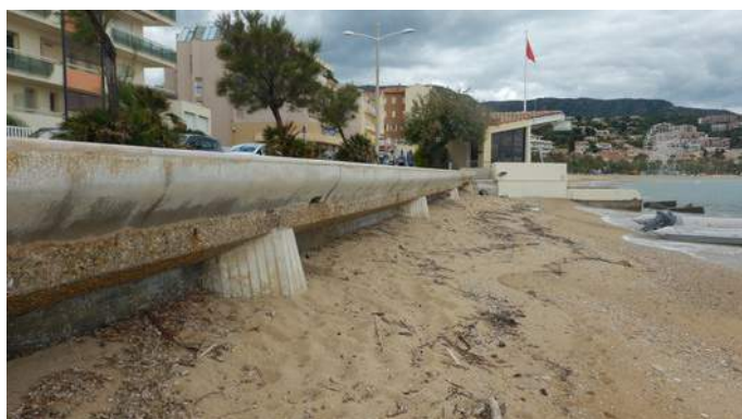
Photographie 19: Mur de soutènement, commune du Lavandou
