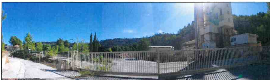
Figure 10: photographie du site "Toulon enrobés Evenos"
