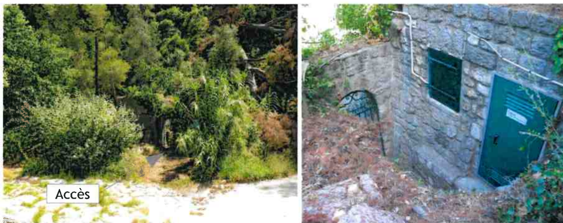
Figure 4: photographies de l'accès au captage de la Mère des Fontaines
