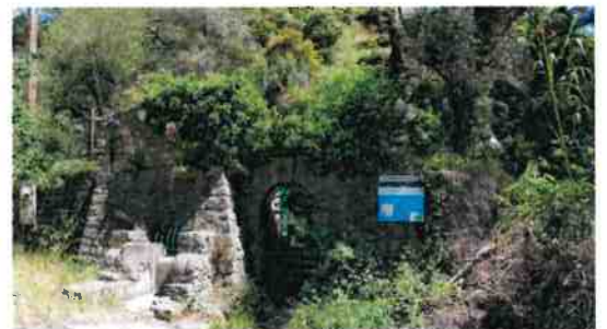
Nettoyage du site de captage, coupe de la végétation autour et sur le captage
