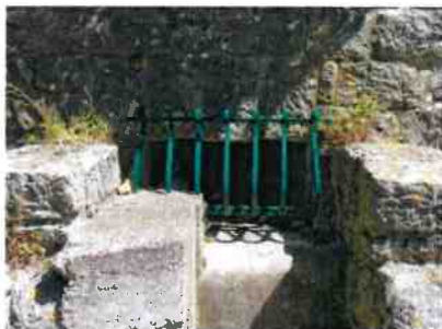
Ajour de grilles d'aération fines afin d'empêcher l'intrusion de petits animaux
