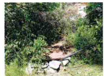
Margelle du puits situé à proximité
