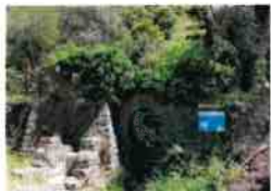
Forage de la source de Fontaines à moitié en ruine
