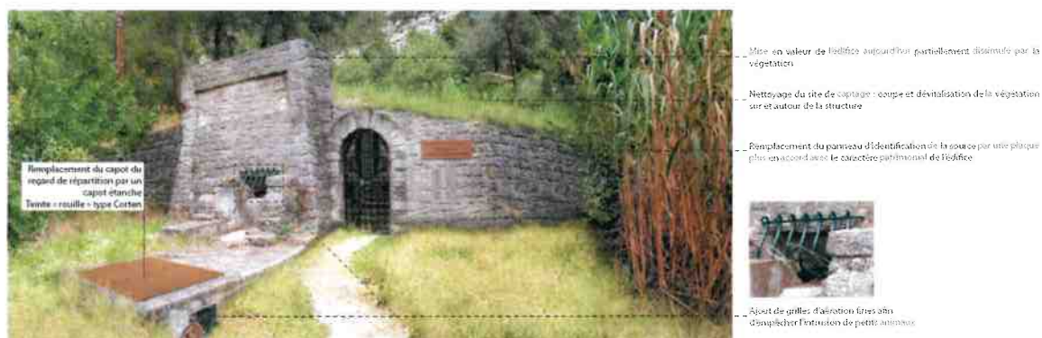
Figure 27 : Extrait de l'étude paysagère dans le cadre de la procédure de protection des captages d'eau. « la Mère des Fontaines », « le Puits du Trou de la Bombe » et « le Forage de la Ripelle » sur la commune d'Ollioules (83) – focus sur les grilles mises en place au niveau des ouvertures de la Mère des Fontaines (Source : Composite, 2017)
