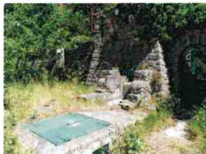
Mise en place d'un capot étanche sur le regard de répartition extérieur avec fermeture adaptée
