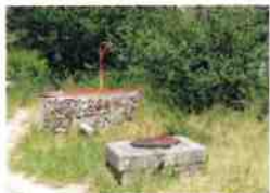
Aspect du Puits du lit mineur de la Bombe et du regard de comptage à son bord
