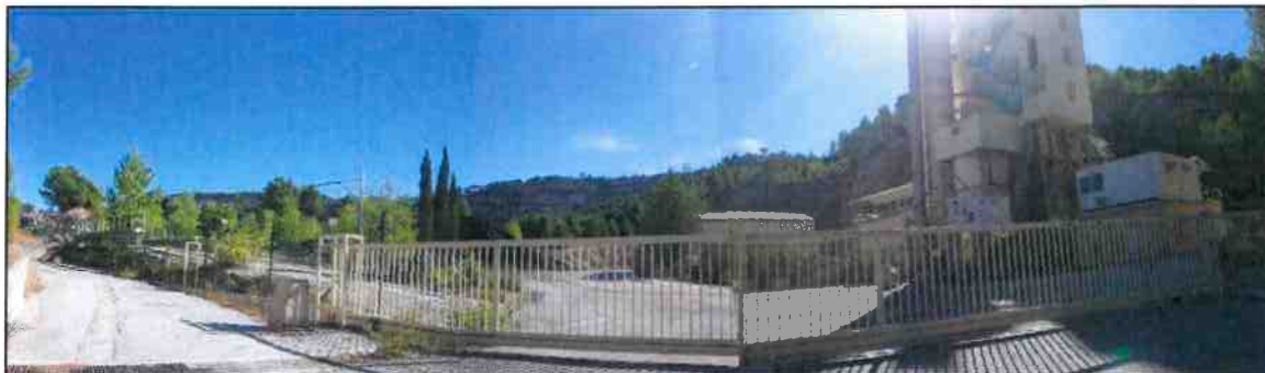
Figure 12: photographie du site "Toulon enrobés Evenos"
