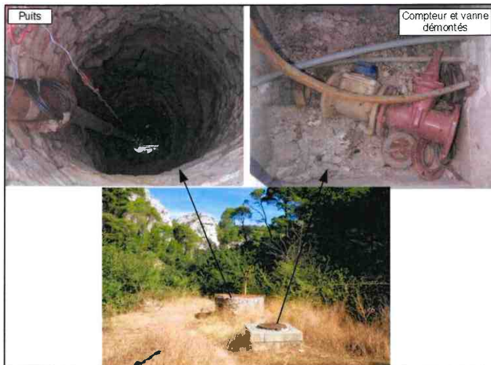
Figure 7: photographies du puits du Trou de la Bombe
