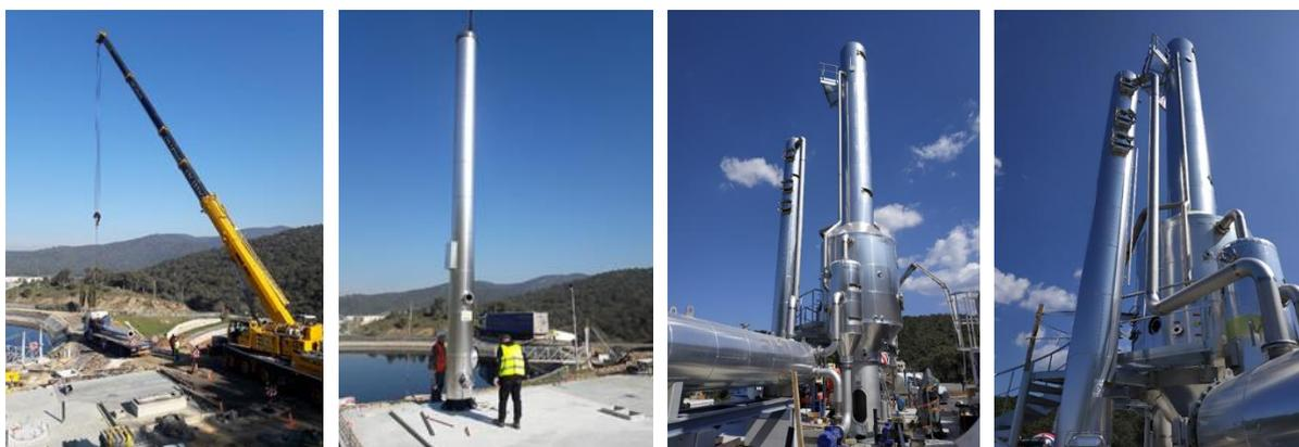
Figure 19. Mise en place de l'évaporateur
