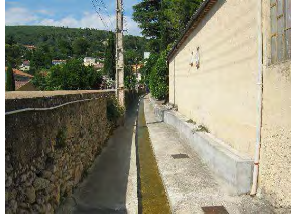
Photos 96 : Vallon de la Riaille – tronçon détourné à l'Ouest du Clos Jean Icard (Juin 2011)
