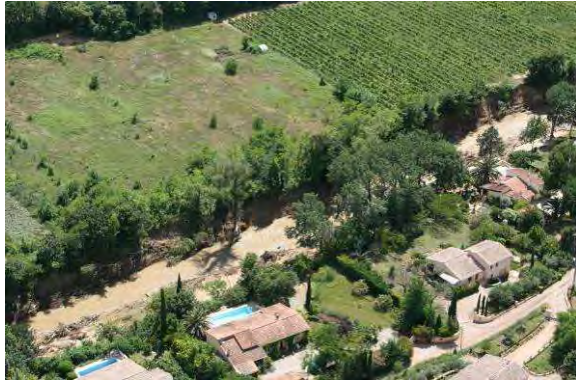
Photos 127 : Aval de La Motte – Quartier des Courrens– Vue post crue
