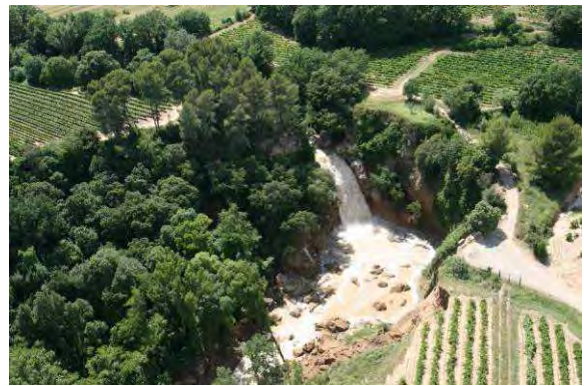
Photos 124 : Saut du Capellan - Vue post crue
