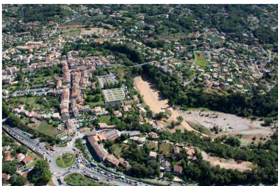
Photos 115 : La Nartuby en aval de Trans – Vue post crue
