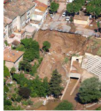
Photos 39 : Sortie de l'ouvrage – post crue – Le Réal aux Arcs
