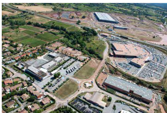
Photos 50 : Le Réal en amont de la RD7N et la ZAC des Bréguières au second plan - Post crue
