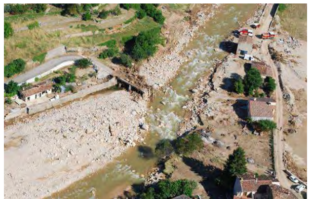
Photos 69 : La Nartuby à Rebouillon – Post Crue
