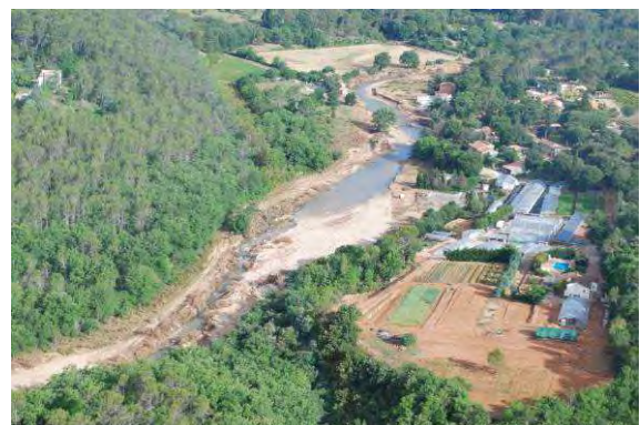
Photos 33 : La Florièye à Lorgues - Érosion dans le secteur des Pailles - Post crue
