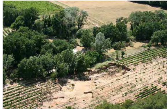
Photos 118 : La Nartuby au niveau de la prise d'eau dit l'Écluse (Canal du Muy) – Post crue
