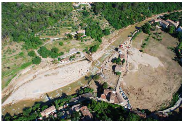
Photos 68 : La Nartuby à Rebouillon – Post Crue
