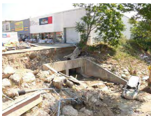
Photos 98 : Exutoires à la Nartuby (V. Pompidou) La Riaille (à gauche) et Galerie du canal (à droite)
