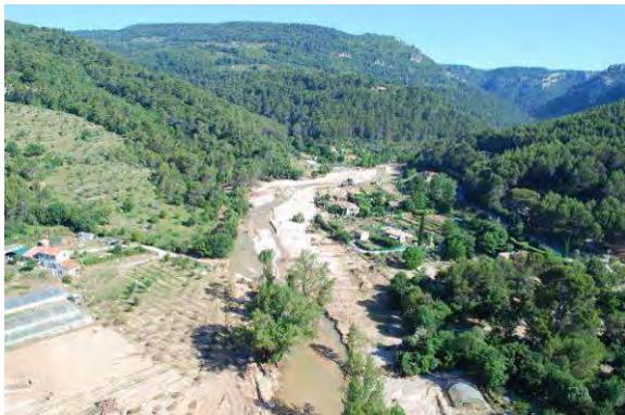
Photos 70 : La Nartuby secteur Granegone – Post Crue
