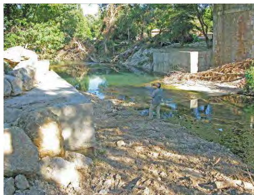
Photos 91 : Seuil et rétrécissement au pont de l'ancienne voie ferrée - Post Crue
