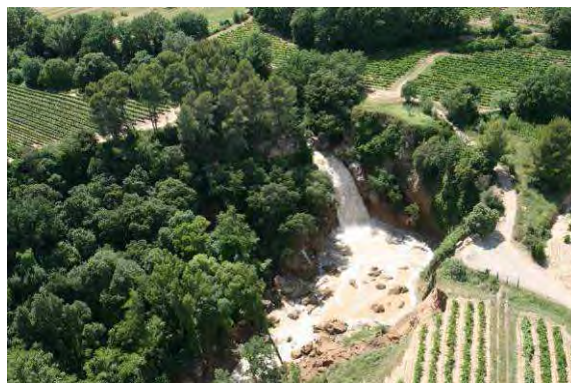
Photos 124 : Saut du Capellan - Vue post crue
