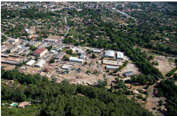
Photos 88 : Vues générales post crue – du pont de Lorgues à l'ancienne - Voie ferrée
