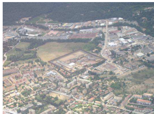
Photos 83 : La prison de Draguignan – témoin de zone d'écoulement – vue décrue source DREAL
