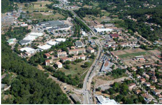
Photos 105 : Vue de la voie express et du « Carrefour » – Trans en Provence - vue post crue
