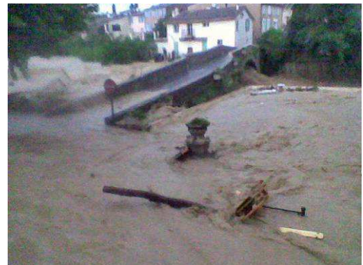
Photos 110 : Le Pont Vieux le 15-06-2010 - déversement sur le parapet amont en rive droite.
