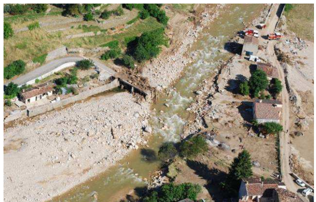
Photos 69 : La Nartuby à Rebouillon – Post Crue
