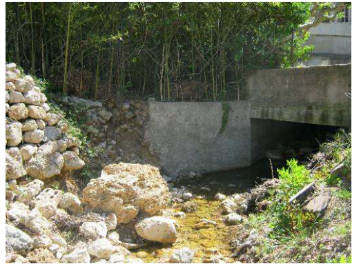
Photos 138 : Figanières – La Tuilière – entrée du passage couvert obstruée et insuffisante en juin 2010
