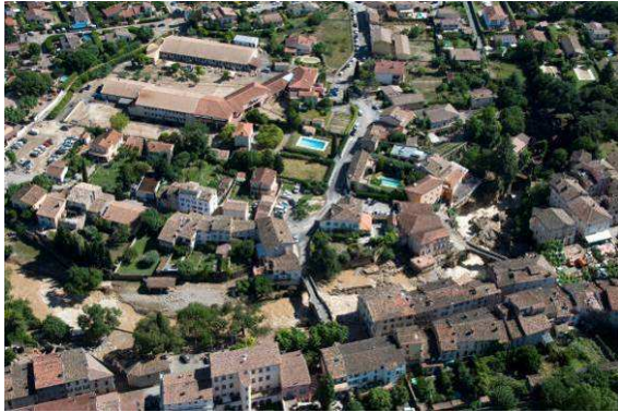
Photos 111 : Trans en Provence centre – Post Crue
