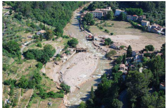
Photos 67 : La Nartuby à Rebouillon – Post Crue
