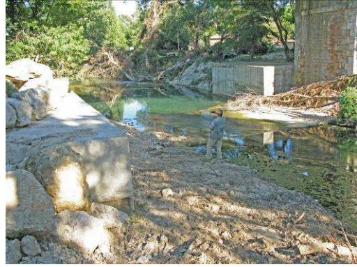
Photos 91 : Seuil et rétrécissement au pont de l'ancienne voie ferrée - Post Crue
