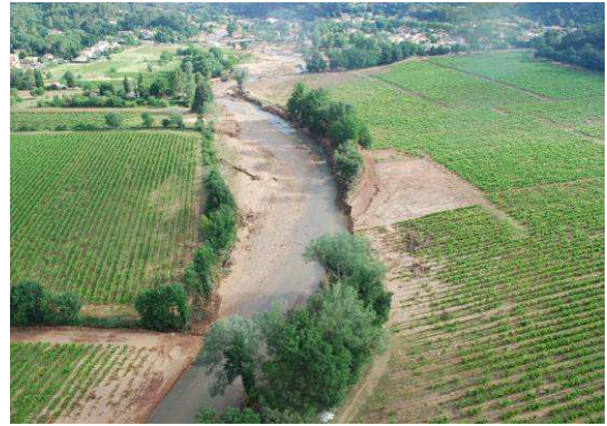
Photos 37 : Aval de Taradeau – La Florièye Post crue
