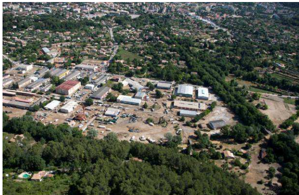
Photos 88 : Vues générales post crue – du pont de Lorgues à l'ancienne - Voie ferrée
