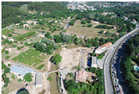
Photos 92 : Aval de l'ancienne voie ferrée - vue quartier des Incapis depuis l'aval -Post Crue
