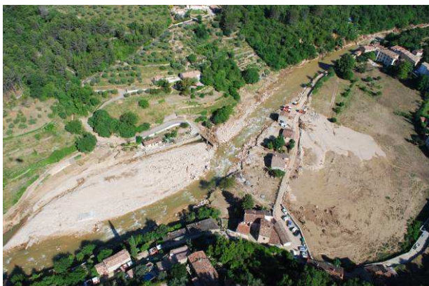
Photos 68 : La Nartuby à Rebouillon – Post Crue
