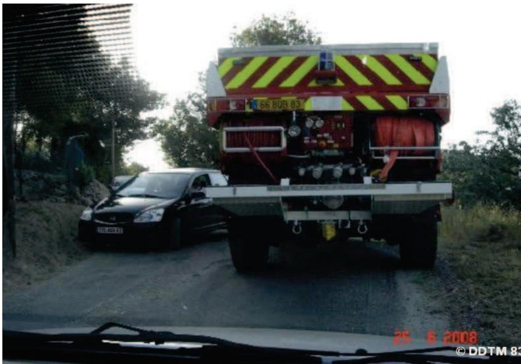
Pour croiser des véhicules des personnes quittant leur habitation, dont la largeur moyenne est d'environ 1,6 m, une largeur d'emprise de 5 m est nécessaire ; pour des largeurs inférieures, des manœuvres périlleuses obligeant à s'engager sur les accotements dont la stabilité n'est pas garantie pour des véhicules lourds comme les camions feux de forêts sont indispensables, ce qui dans ce cas également ralentit fortement l'acheminement des secours.
