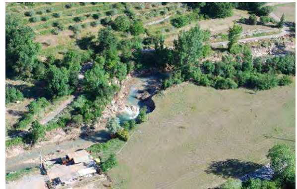
Photos 59 : La Nartuby à la Tuilière– Post crue
