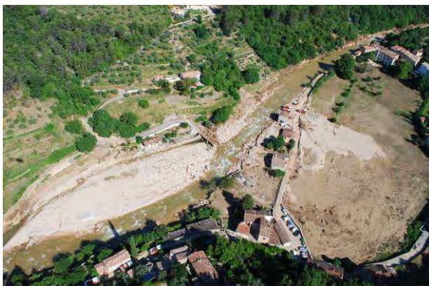
Photos 68 : La Nartuby à Rebouillon – Post Crue
