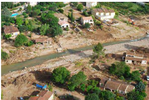
Photos 34 : Amont du Pont de la RD10 – Florièvre à Taradeau - Post crue
