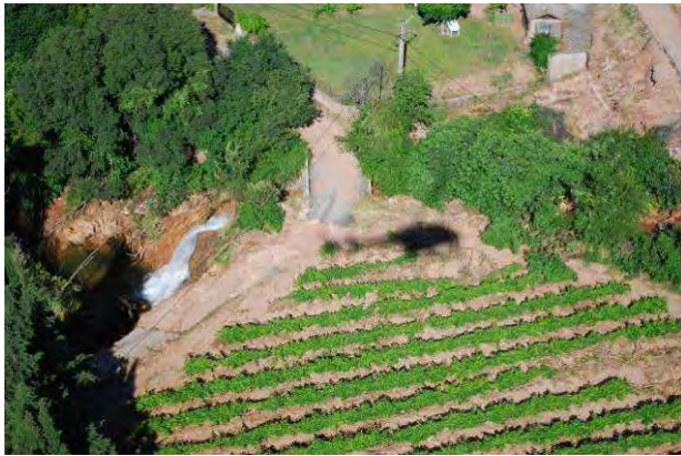
Photos 48 : Le Sainte Cécile au niveau du quartier Les Valettes aux Arcs - Post crue
