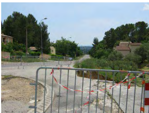
Photos 30 : Le Réal Calamar à Lorgues - Post crue
