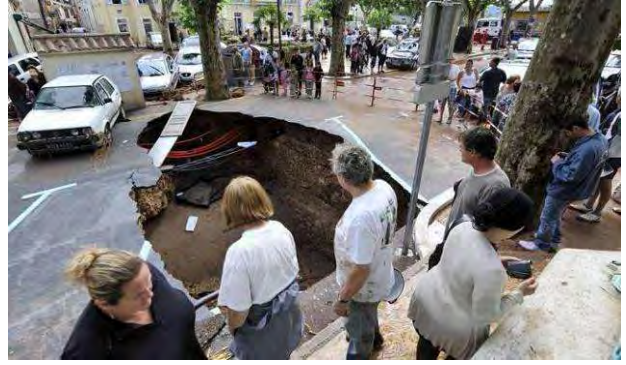
Photos 45 : Le Réal dans le centre ville des Arcs – dégâts au niveau du passage souterrain – Vue post crue
