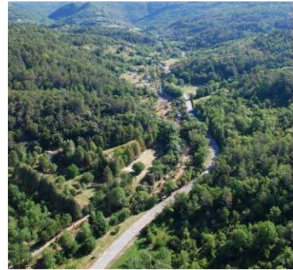
Photos 57 : La Nartuby entre Montferrat et le Plan Châteaudouble– Premières zones de débordements importants (aval Vallon de Bivosque– Post crue)
