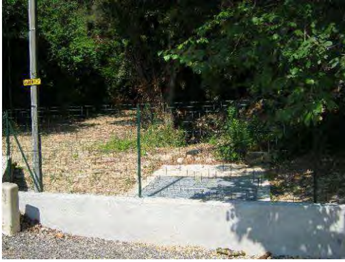
Photos 95 : Vallon de la Riaille – engouffrement actuel sous le Bvd Collomp (Juin 2011)
