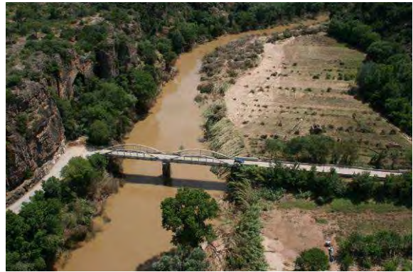
Photos 15 : L'Argens au niveau de la RD25 – Vue vers l'amont – photo post Crue
