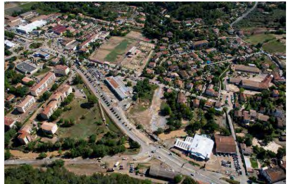
Photos 106 : Vue de la voie express et du Pont Vieux – Trans en Provence - vue post crue
