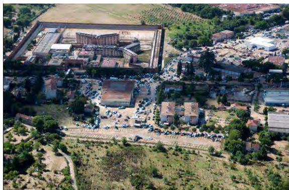
Photos 82 : La prison de Draguignan – témoin de zone d'écoulement – vue post Crue
