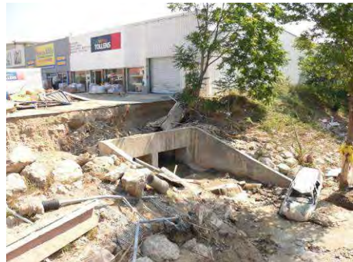
Photos 98 : Exutoires à la Nartuby (V. Pompidou) La Riaille (à gauche) et Galerie du canal (à droite)
