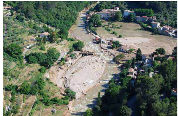
Photos 67 : La Nartuby à Rebouillon – Post Crue
