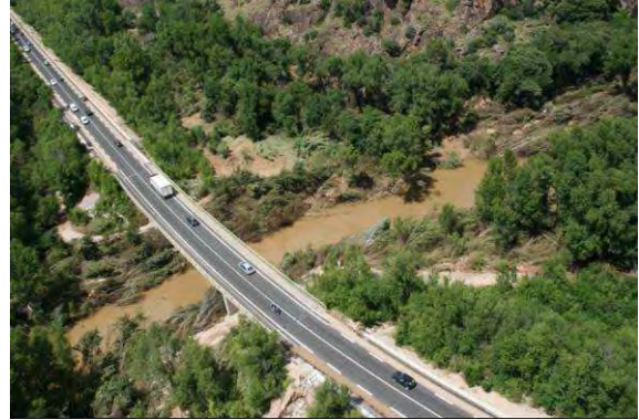
Photos 17 : L'Argens au droit amont de la RD125 - photo Post Crue
