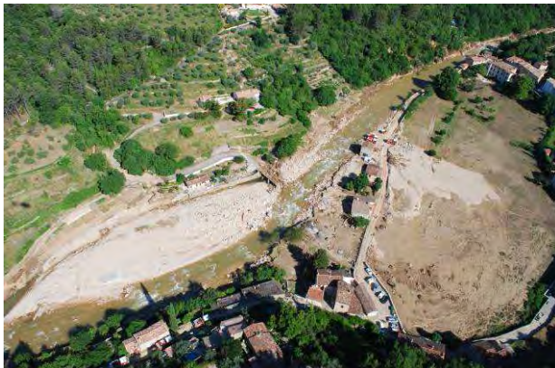
Photos 68 : La Nartuby à Rebouillon – Post Crue
