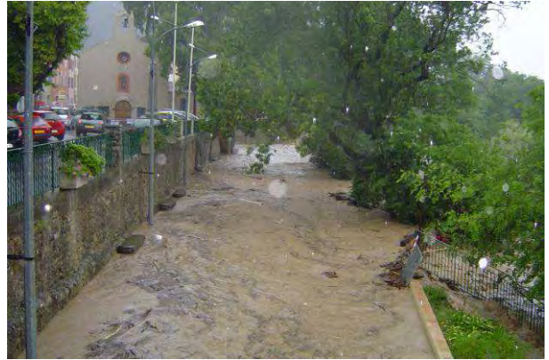
Photos 112 : Trans en Provence centre – Post Crue
