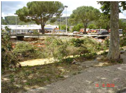
Photos 107 : Carrefour Trans en Provence – vue post crue
