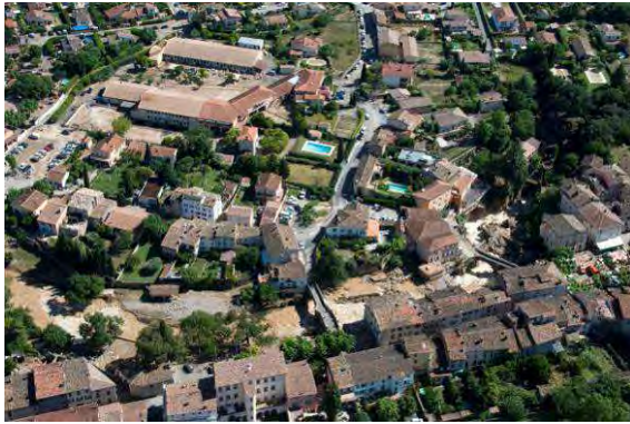
Photos 111 : Trans en Provence centre – Post Crue
