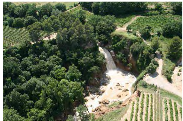
Photos 124 : Saut du Capellan - Vue post crue
