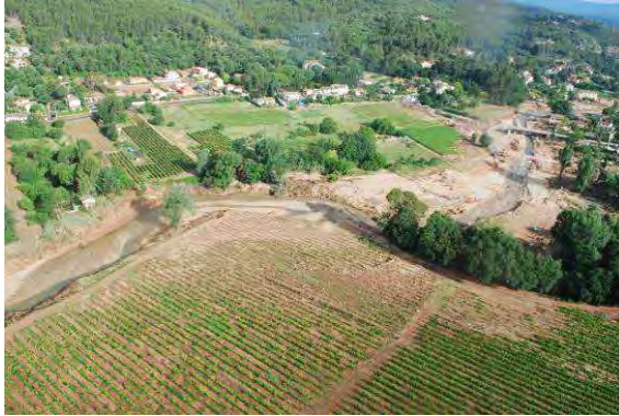
Photos 36 : Aval et pont de la RD10 – Florièye à Taradeau - Post crue
