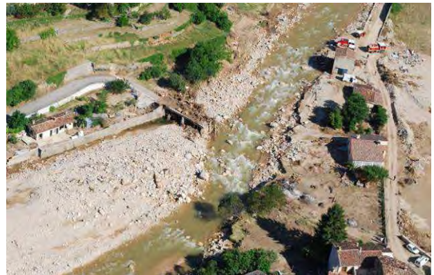
Photos 69 : La Nartuby à Rebouillon – Post Crue
