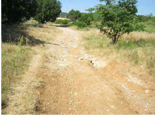
Photos 103 : Vallon Sainte Barthe : Secteur Sainte Barthe
