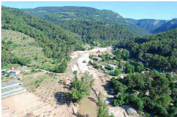
Photos 70 : La Nartuby secteur Granegone – Post Crue
