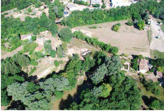
Photos 90 : Ancienne voie ferrée - vue depuis l'aval -Post Crue
