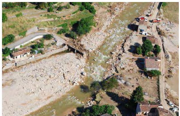
Photos 69 : La Nartuby à Rebouillon – Post Crue
