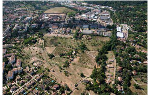
Photos 81 : La Nartuby et son axe de déversement au niveau de Petit Plan / prison – vue post Crue
