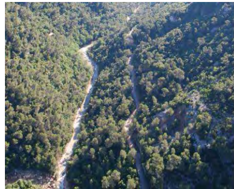
Photos 55 : La Nartuby d'Ampus au débouché dans les Gorges de Châteaudouble (en bas à gauche) – post crue
