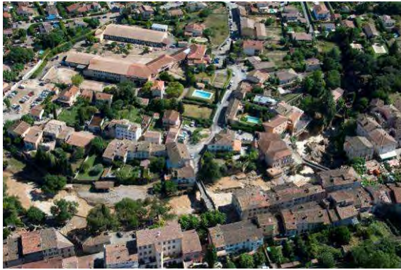
Photos 111 : Trans en Provence centre – Post Crue
