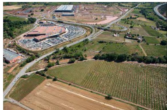
Photos 51 : Le Réal en aval de la RD7N et la ZAC des Bréguières au second plan - Post crue
