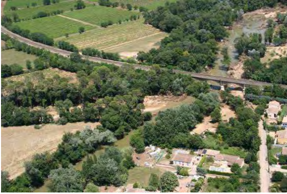
Photos 6 : L'Argens à la confluence avec la Florièvre – Vidauban (photo post crue)
