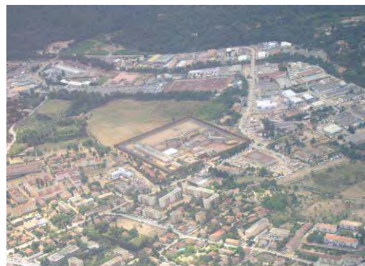
Photos 83 : La prison de Draguignan – témoin de zone d'écoulement – vue décrue source DREAL
