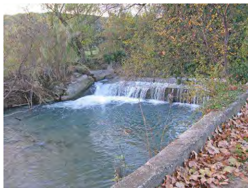
Photos 94 : Seuil de prise d'eau sur la Nartuby en aval du confluent avec la Foux
