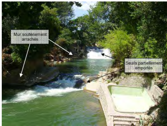
Photos 131 : Le Muy – Moulin de Serres – Vue post crue – source EGIS EAU
