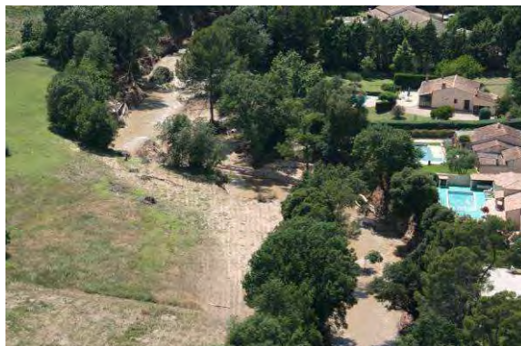
Photos 128 : Aval de La Motte – Quartier des Courrens– Vue post crue
