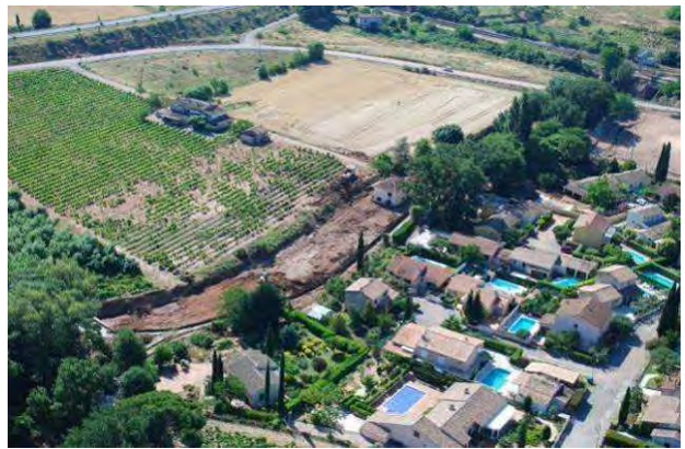
Photos 47 : Le Réal en aval immédiat de la confluence avec le Sainte Cécile – Enjeux en lit moyen –vue post crue
