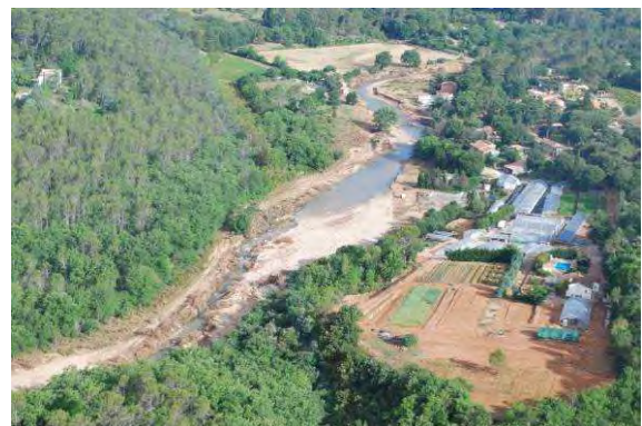
Photos 33 : La Florièye à Lorgues - Érosion dans le secteur des Pailles - Post crue
