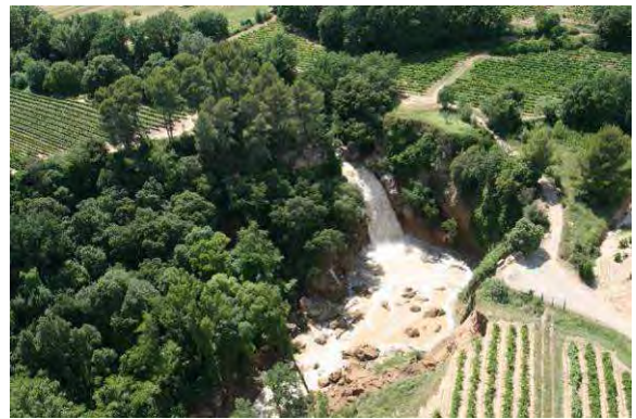
Photos 124 : Saut du Capellan - Vue post crue
