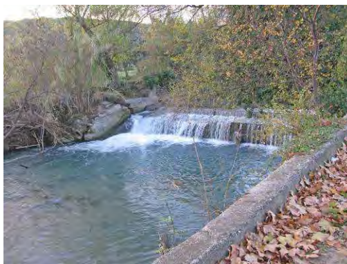
Photos 94 : Seuil de prise d'eau sur la Nartuby en aval du confluent avec la Foux
