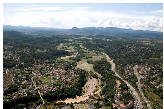
Photos 116 : La Nartuby en aval de Trans – Vue post crue
