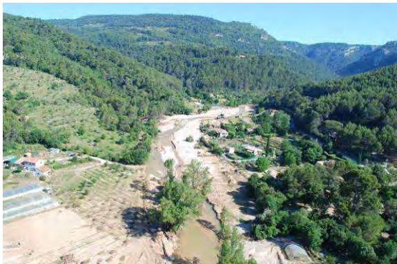
Photos 70 : La Nartuby secteur Granegone – Post Crue
