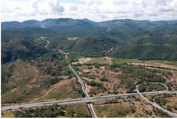
Photos 16 : L'Argens et les Déguiers en amont immédiat de la RD125-photo Post Crue
