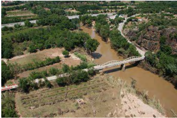
Photos 14 : L'Argens au niveau de la RD25 – Vue vers l'aval – photo post Crue
