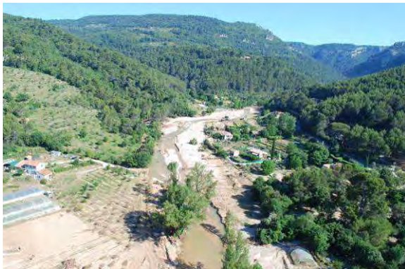
Photos 70 : La Nartuby secteur Granegone – Post Crue
