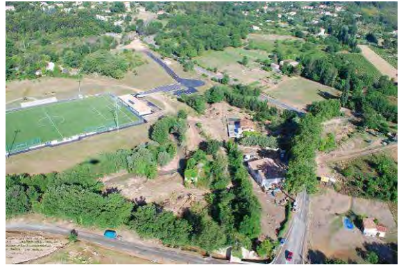
Photos 31 : Le Figueiret en aval de Flayosquet - Post crue
