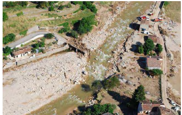
Photos 69 : La Nartuby à Rebouillon – Post Crue
