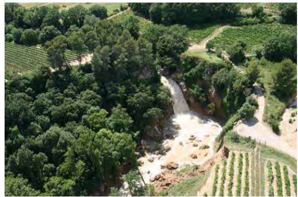
Photos 124 : Saut du Capellan - Vue post crue
