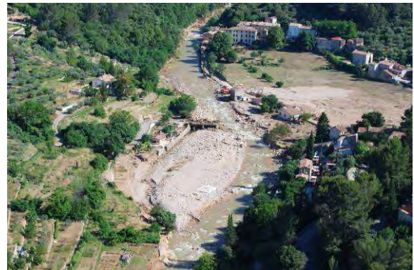
Photos 67 : La Nartuby à Rebouillon – Post Crue
