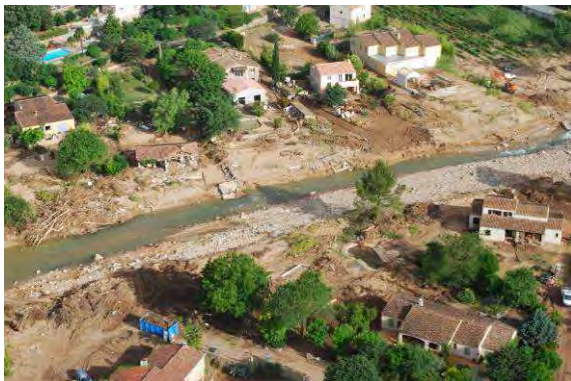
Photos 34 : Amont du Pont de la RD10 – Florièye à Taradeau - Post crue
