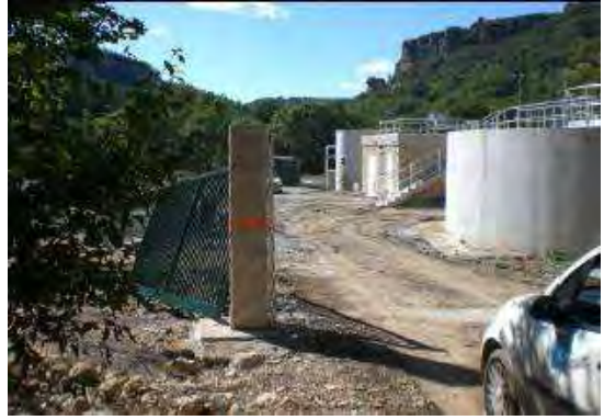
Photos 61 : La Nartuby au Plan - Station d'épuration- Post crue
