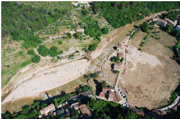
Photos 68 : La Nartuby à Rebouillon – Post Crue
