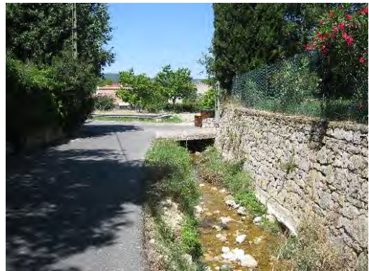
Photos 100 : Vallon des Tours Chemin du Vallon des Tours
