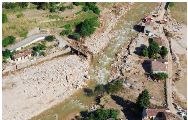
Photos 69 : La Nartuby à Rebouillon – Post Crue
