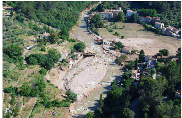
Photos 67 : La Nartuby à Rebouillon – Post Crue
