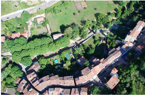
Photos 56 : La Nartuby à Montferrat – Pont endommagé – Post crue
