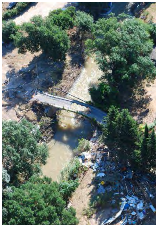
Photos 89 : Pont du chemin des Incapis - Post Crue
