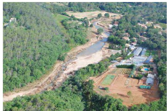
Photos 33 : La Floriège à Lorgues - Érosion dans le secteur des Pailles - Post crue
