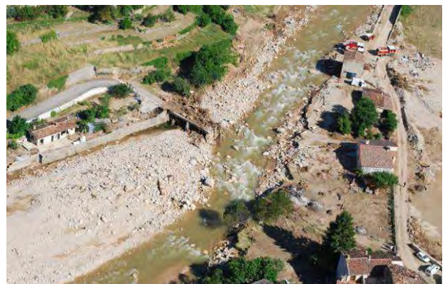
Photos 69 : La Nartuby à Rebouillon – Post Crue
