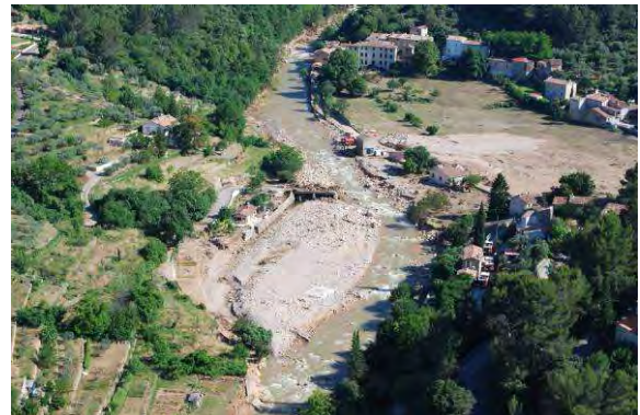
Photos 67 : La Nartuby à Rebouillon – Post Crue
