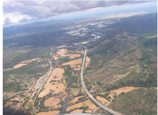
Photos 21 : L'Argens dans la plaine, du Muiy à la Mer - Source DREAL photo oblique
