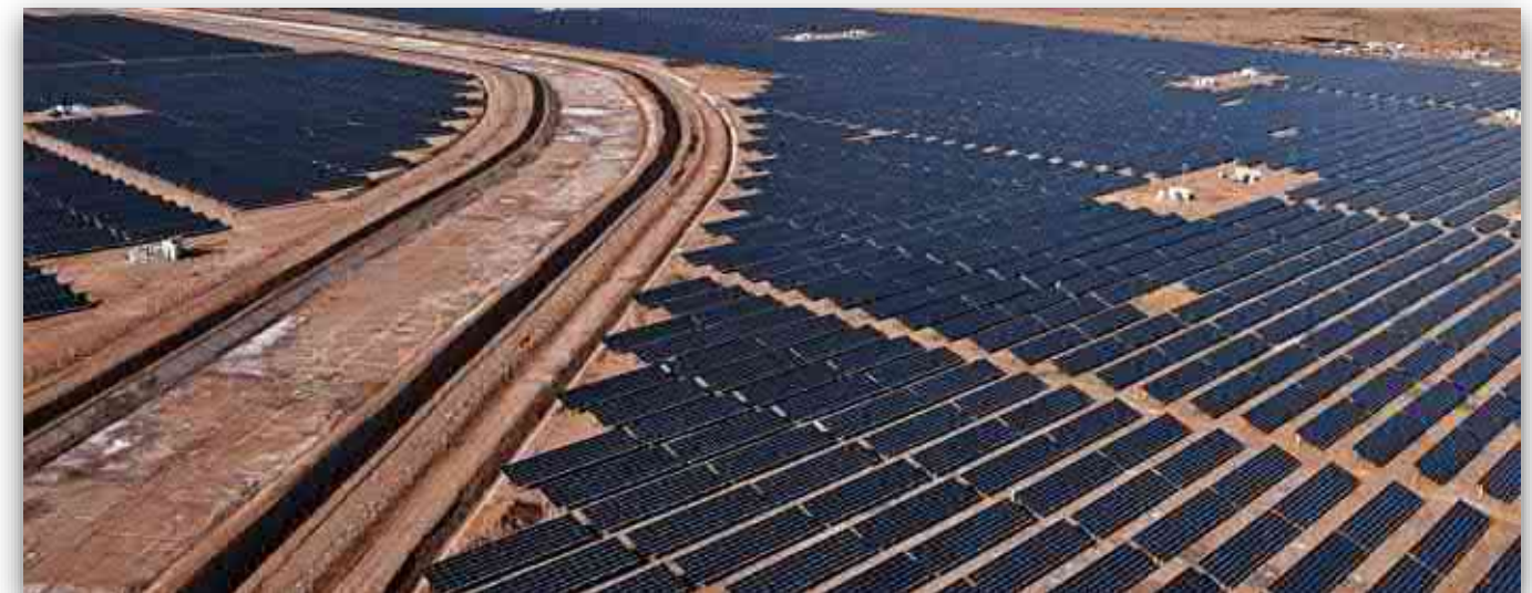
Centrale photovoltaïque au sol de Kamuthi, Inde
