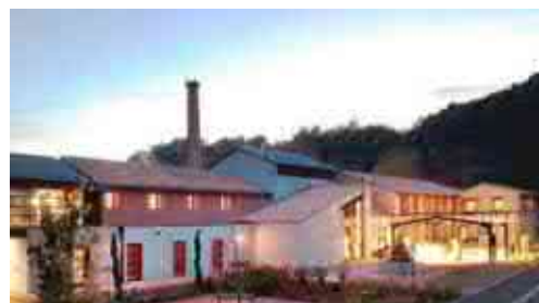
Cheminée du musée Terra Rossa (source : terrarossasalernes.fr)
