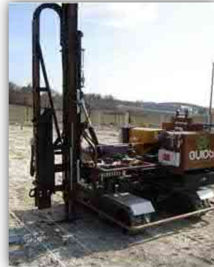
Engin de battage des pieux
