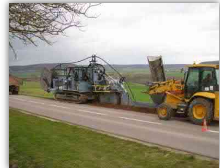
Réalisation de la tranchée
