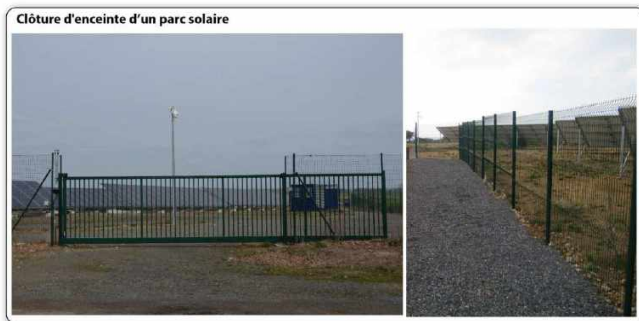
Figure 29 : Clôture de sécurité
