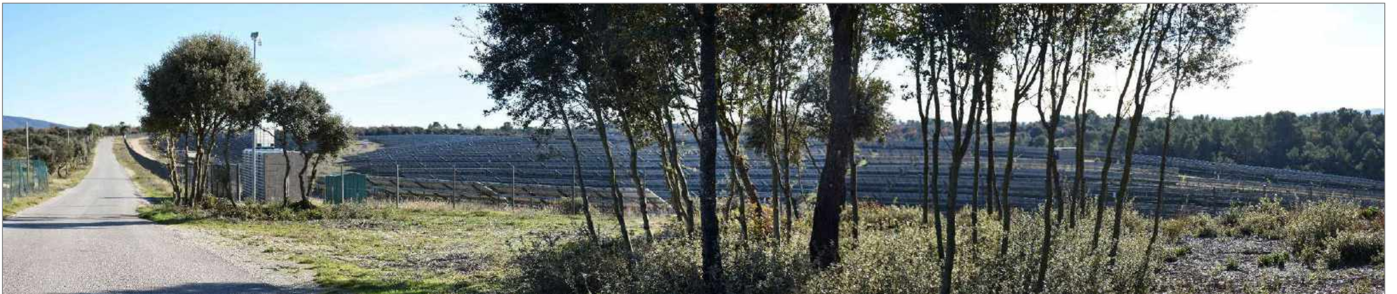
Photographie 52 : Exemples de centrales photovoltaïques au sol similaires à celle de l'Eouvière.
