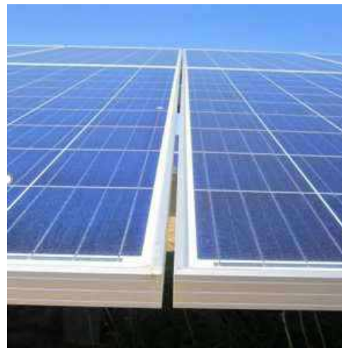
Figure 34 : Effet d'une installation photovoltaïque en plein champ sur l'écoulement de l'eau de pluie
