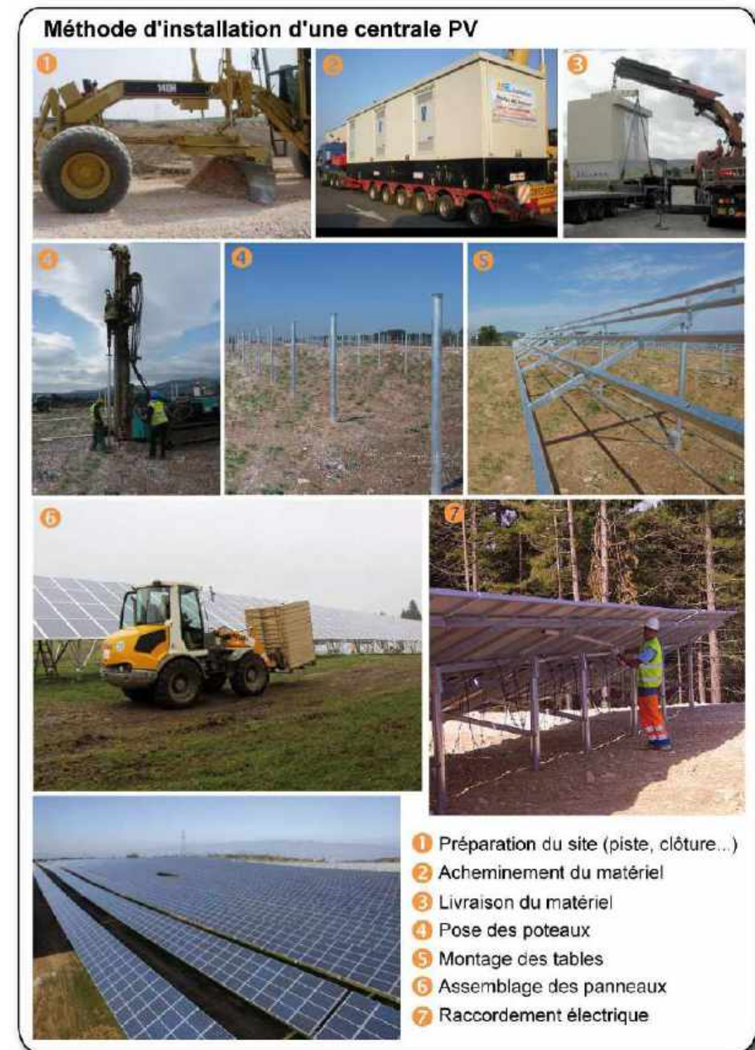
Photographie 49 : Construction d'une centrale photovoltaïque
