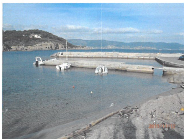
Môle central et cale de mise à l'eau – De gauche à droite : vues depuis la plage, depuis le ponton et vue de la cale de mise à l'eau depuis le terre-plein
