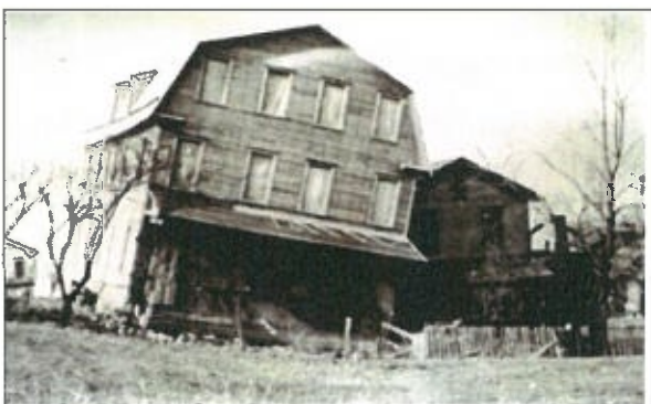
Domage sur une habitation en raison de la survenance d'un affaissement - © GEODERIS
