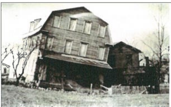
Domage sur une habitation en raison de la survenance d'un affaissement - © GEODERIS
