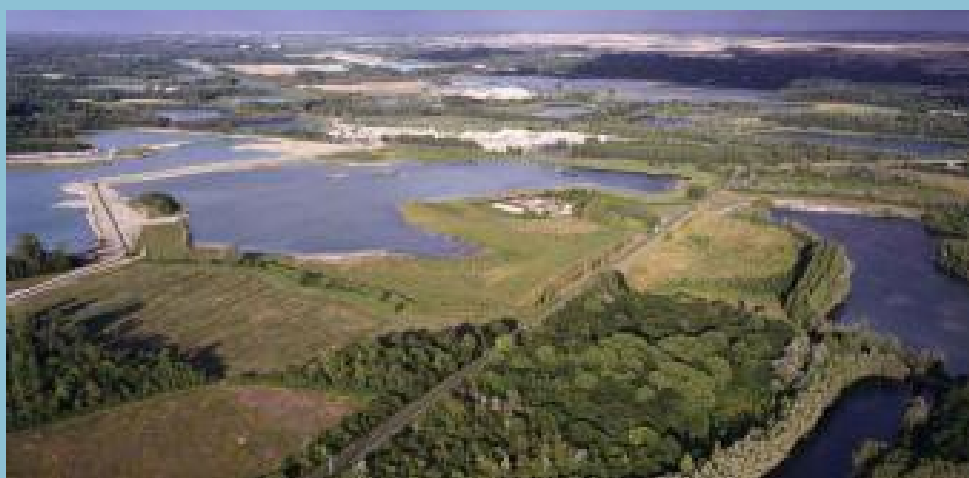
Illustration 37 : photo aérienne de la zone de La Bassée (© EPTB Seine Grands Lacs)
