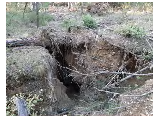
Effondrement (© M. DROUSIE)
