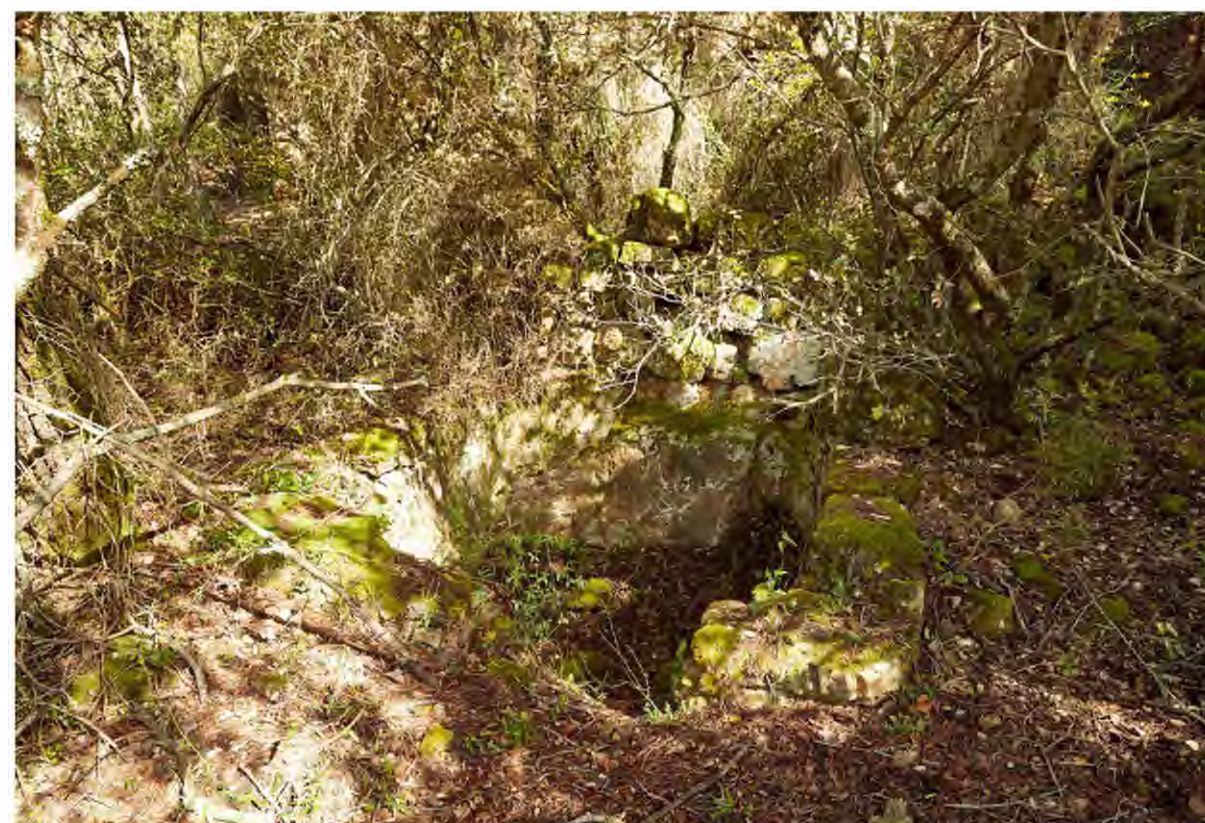
PHOTOGRAPHIE 18 : PRISE DE VUE DE LA RUINE ET DU CAPTAGE DE LA RESURGENCE
