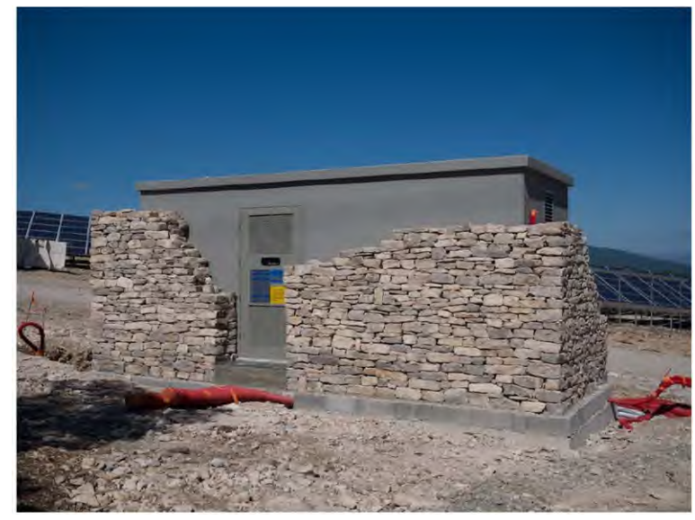
PHOTOGRAPHIE 20 : EXEMPLE D'HABILLAGE DE POSTE DE LIVRAISON (EN COURS DE REALISATION)
