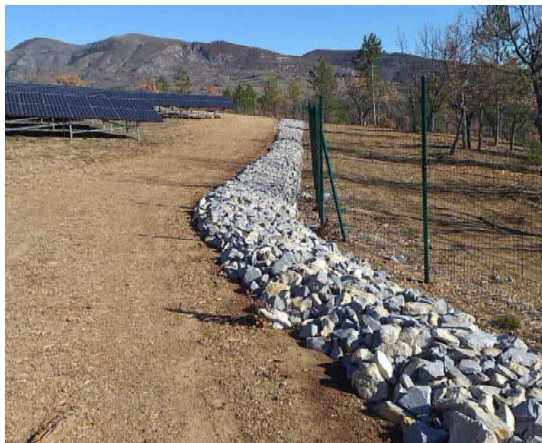
Photographie de pistes périphériques (Source GEOTEC)
