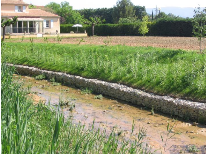
Exemples d'ouvrages : à gauche, pied en gabions, à droite « boudin lesté » ou gabion enfoui sous le lit Pour exemple de tunage, voir action AP 2 sur la Reppe.
