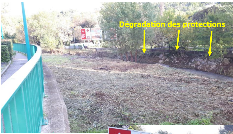
Vue depuis l'aval
