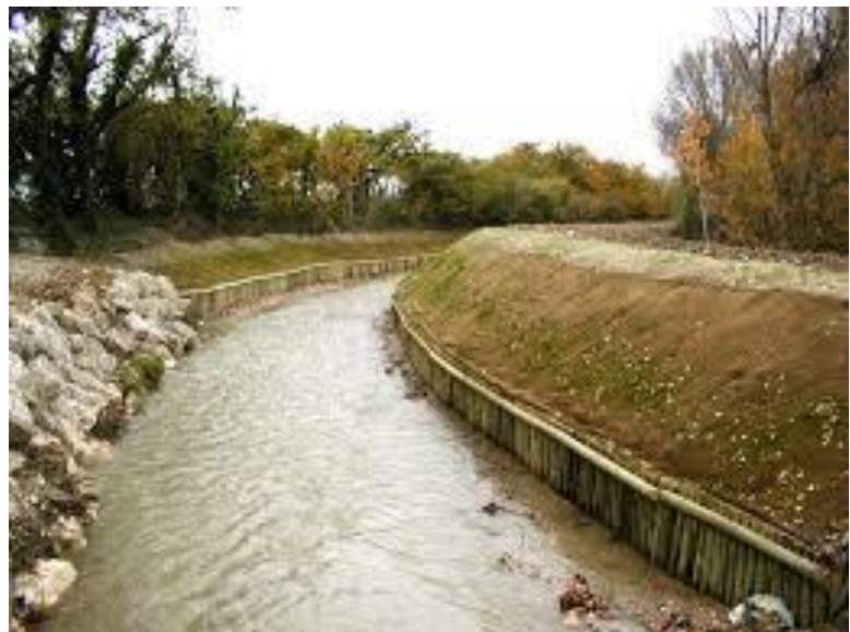
Tunage avec pieux jointifs (alternative aux pieux+planches)
