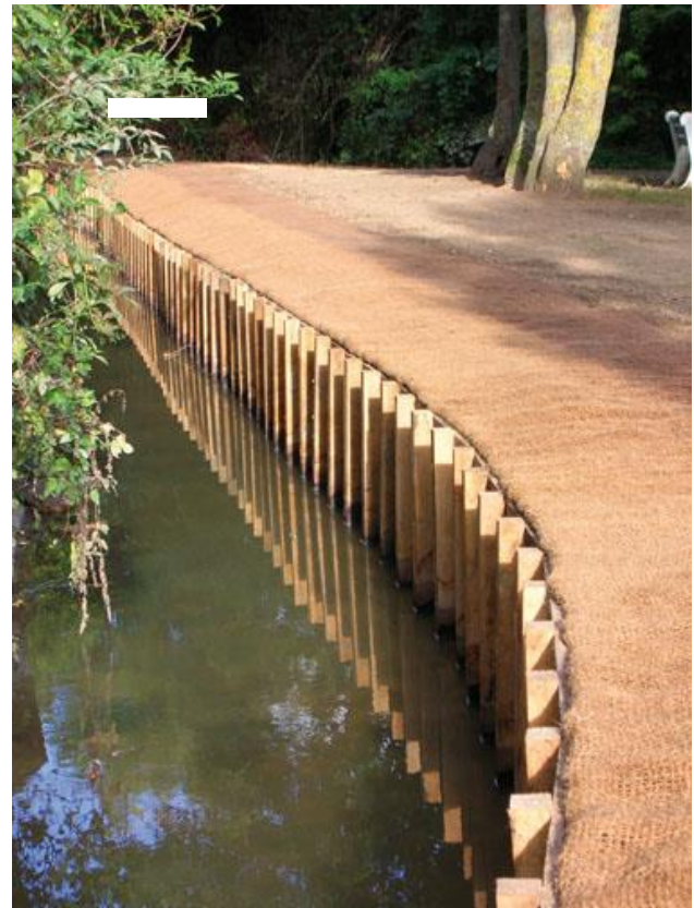
Exemple de tunage avec pieux et planches + feutre coco avant ensemencement
