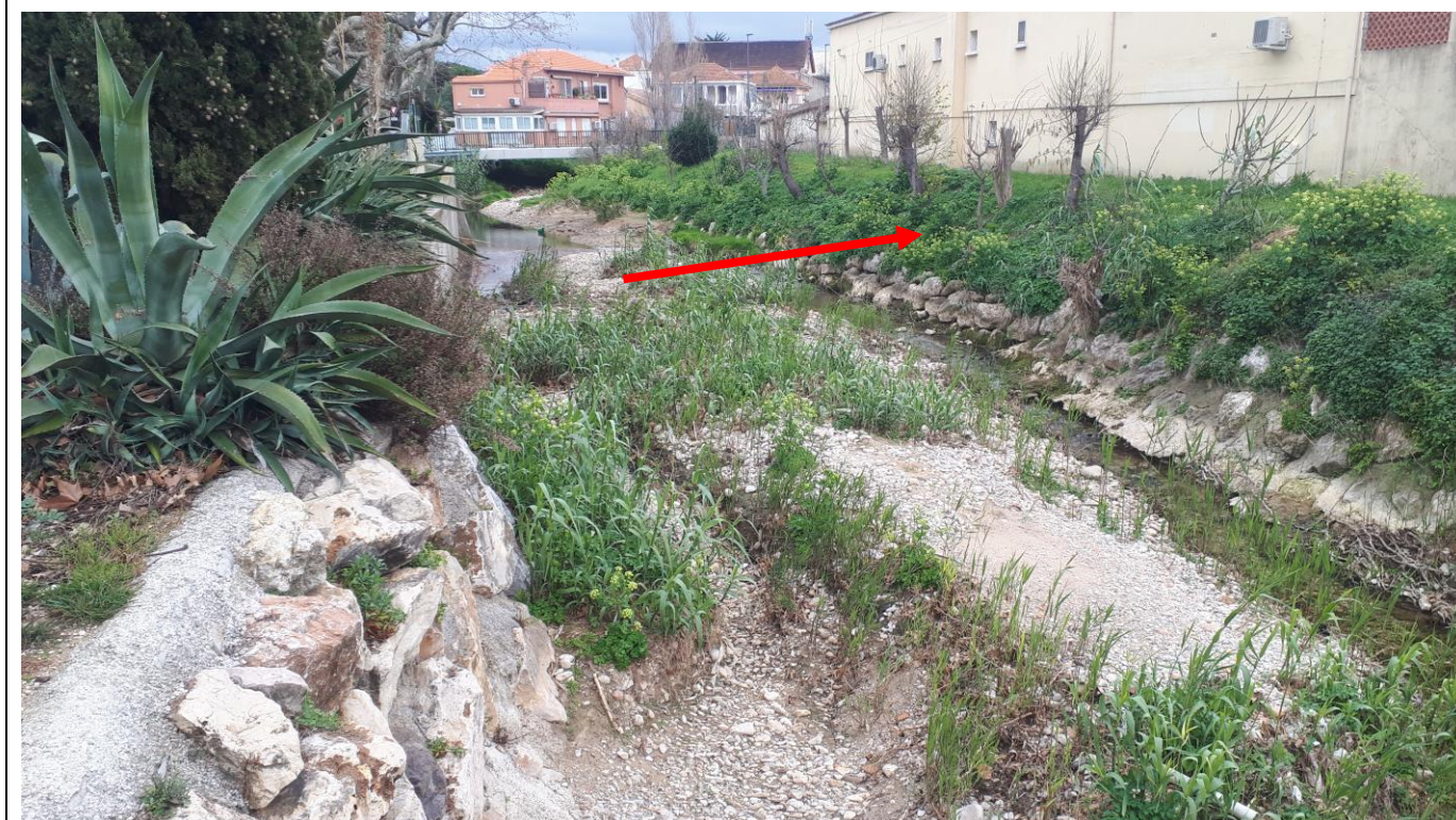
La Reppe le long de la Route de la Gare – Berge à aménager
