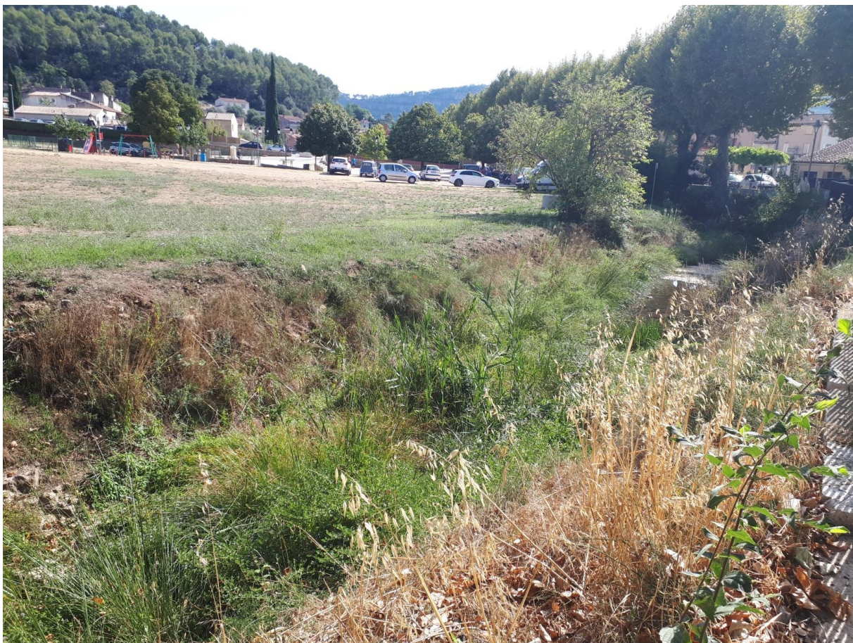
Les berges de la Reppe dans la traversée de Sainte Anne d'Évenos
