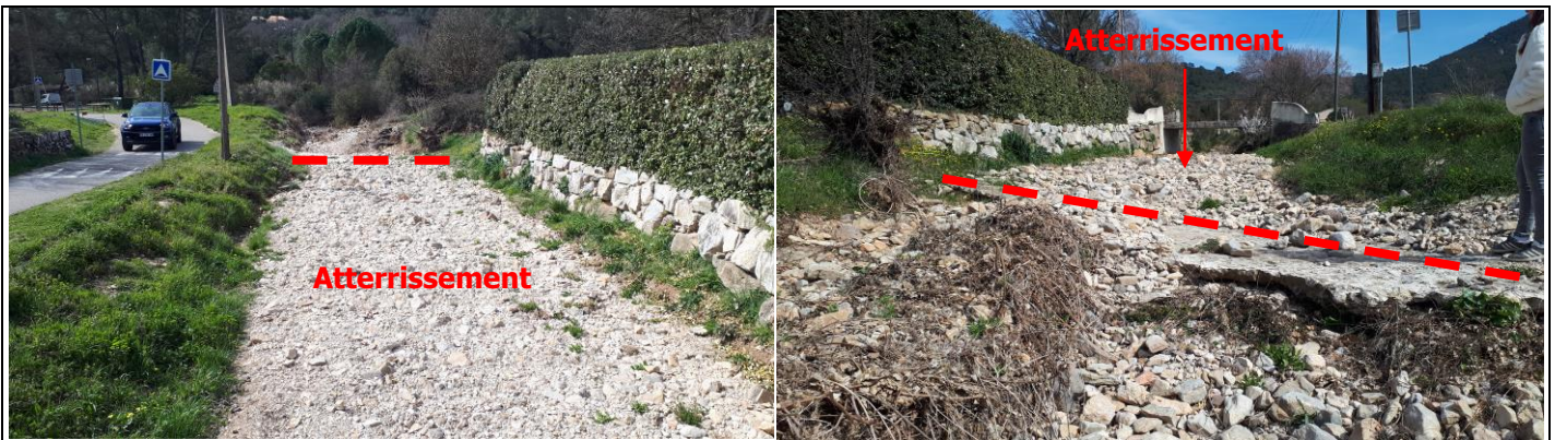
Passage bétonné faisant seuil vu de l'amont
