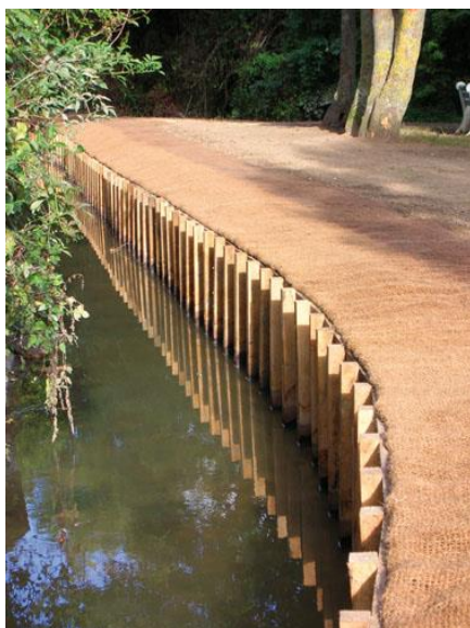
Tunage avec pieux et planches
