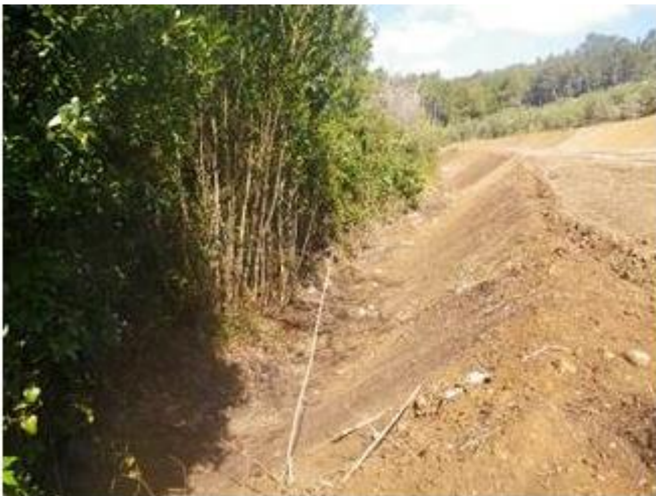
Lit du vallon remblayé, disparation de la végétation
