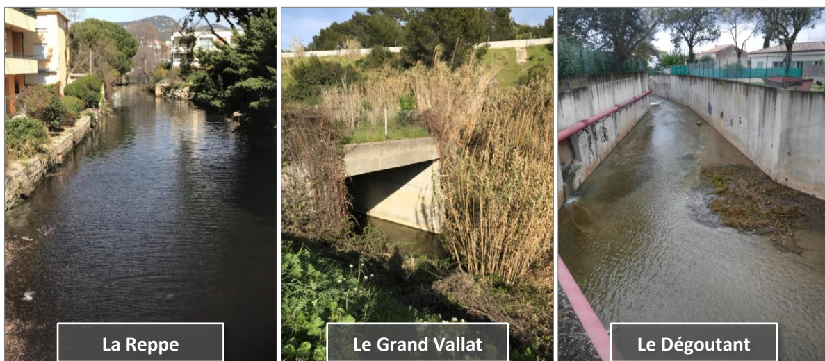
Figure 12 : Photographies illustrant le caractère artificiel des cours d'eau dans la partie aval des bassins versants (Sources : HYDRETUDES, EURYECE)
