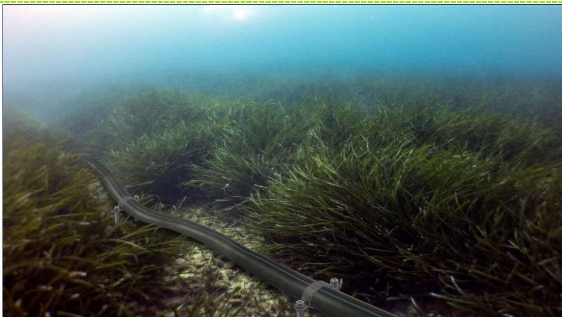
Figure 63. Illustration d'une conduite ancrée sur le fond
