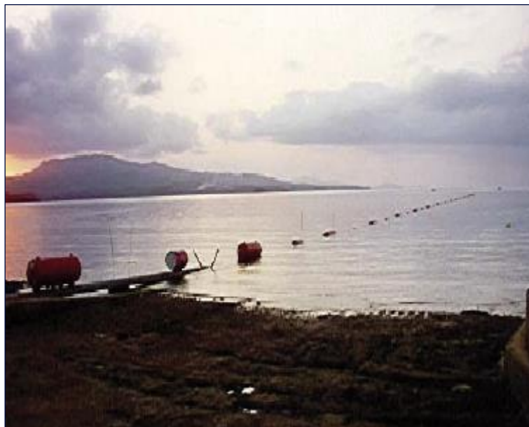
Figure 70. Bouées lors de l'immersion de la canalisation
