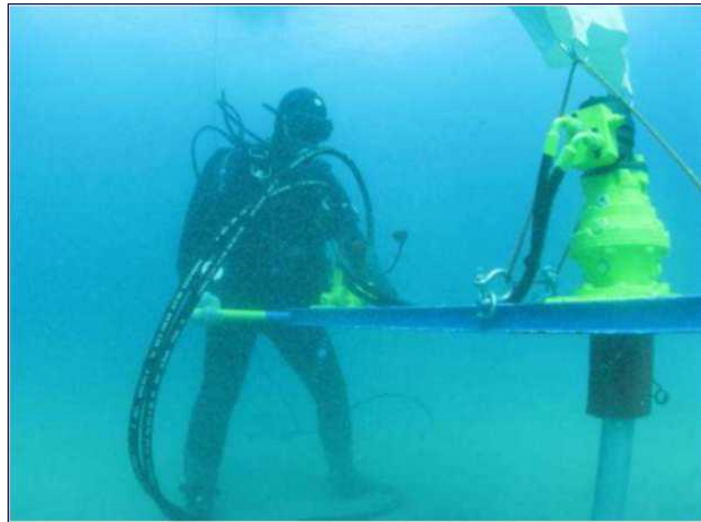
Figure 71. Mise en œuvre des ancres au moyen d'une clé hydraulique
