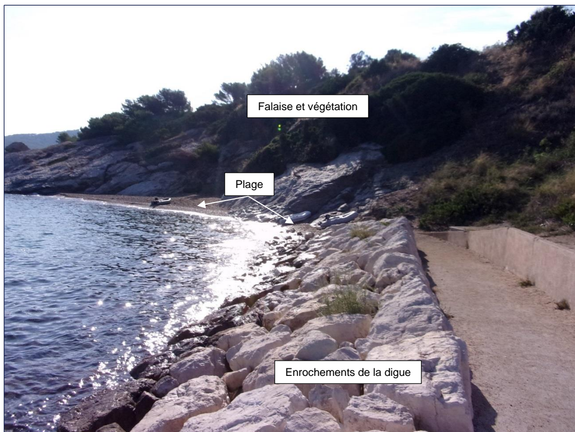
Figure 172. Vue depuis la zone de travaux vers l'Ouest (Source : SUEZ Consulting)
