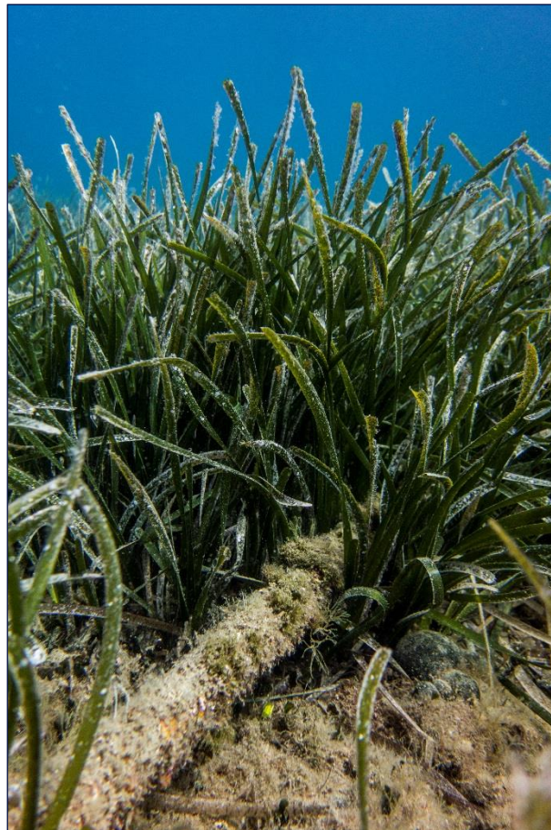
Figure 189. Illustration du recouvrement d'une canalisation par les herbiers de Posidonie (Source : CREOCEAN)
