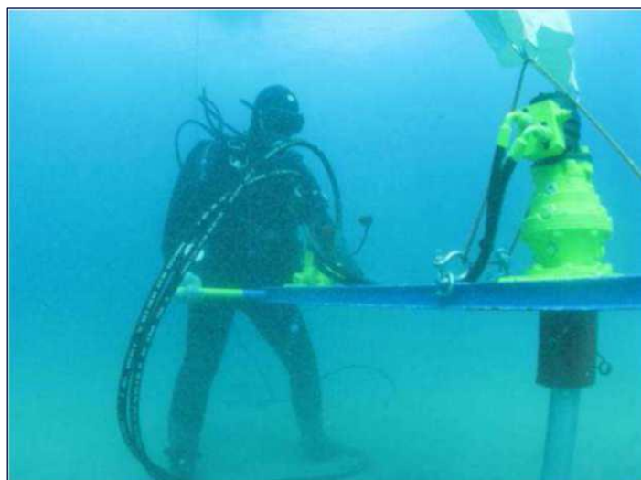
Figure 212. Mise en œuvre des ancres au moyen d'une clé hydraulique
