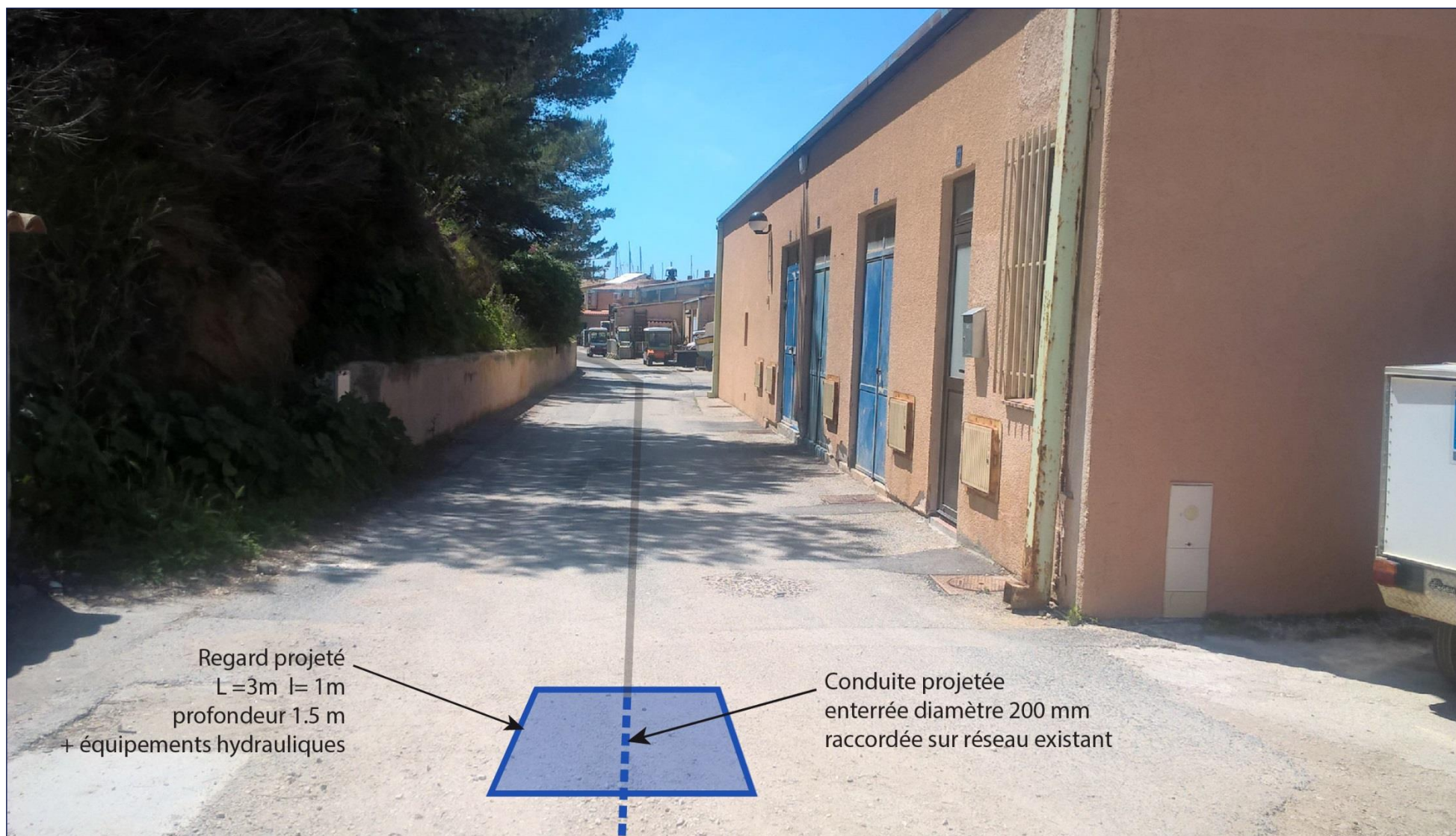
Figure 184. Perceptions de l'arrivée de la canalisation dans le regard projeté : côté Porquerolles
