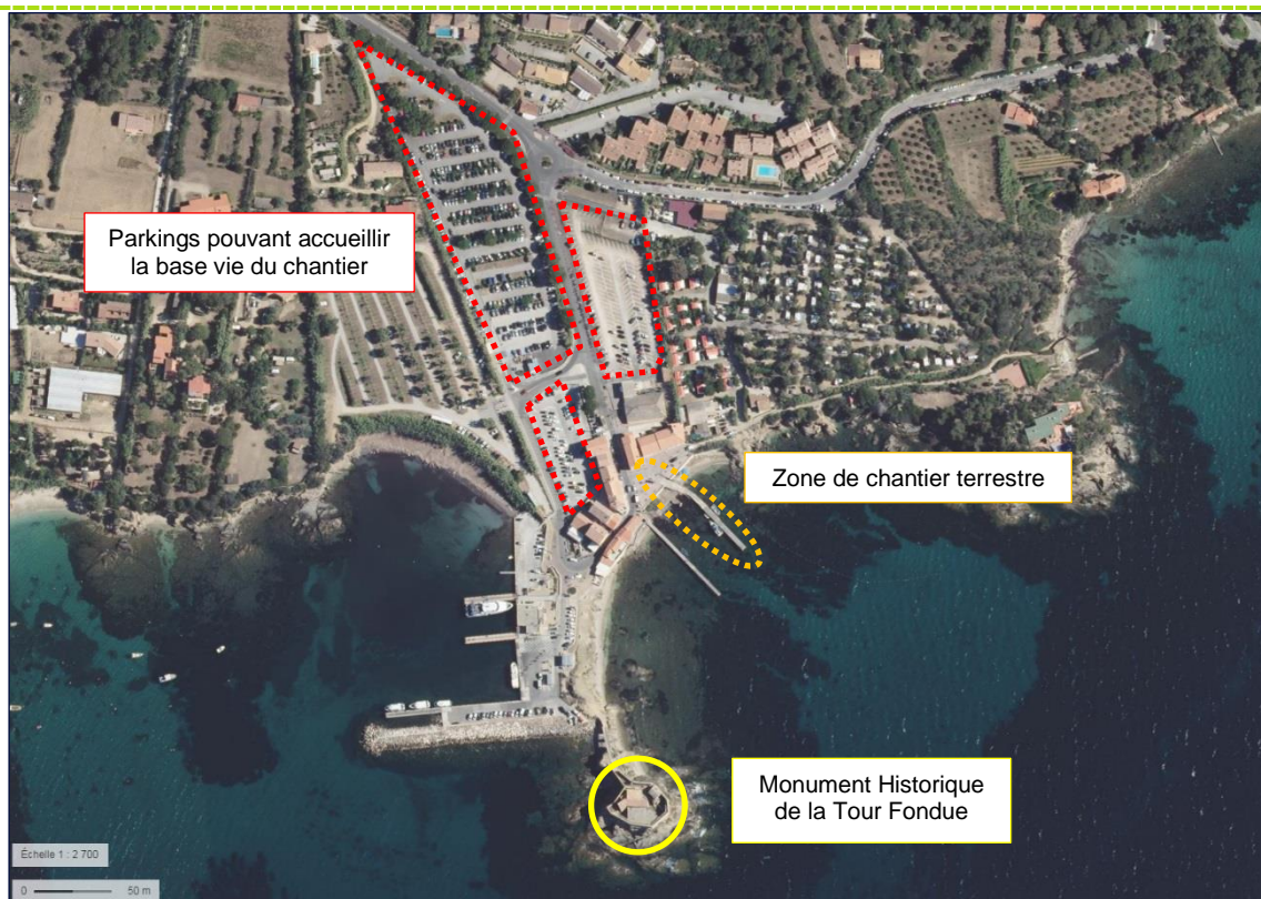
Figure 163. Localisation de la zone de chantier et des zones pouvant accueillir la base vie sur Giens au regard du monument historique de la Tour Fondue (Source : Géoportail)
