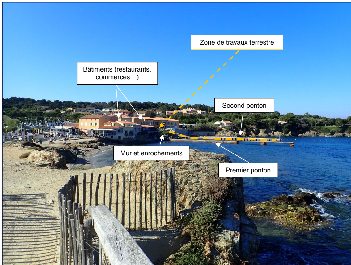
Figure 166. Vue depuis la passerelle d'accès au monument de la Tour Fondue (Source : SUEZ Consulting)
