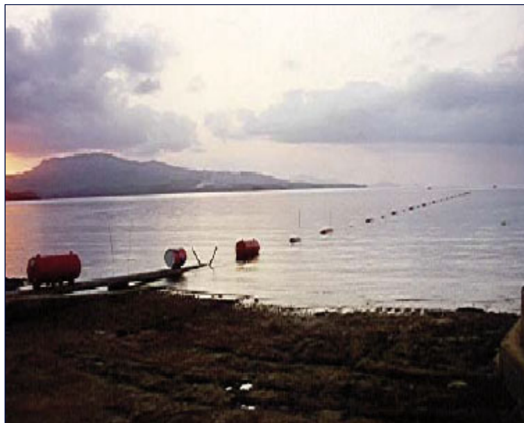
Figure 57. Bouées lors de l'immersion de la canalisation
