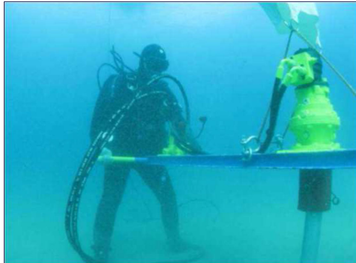
Figure 58. Mise en œuvre des ancres au moyen d'une clé hydraulique
