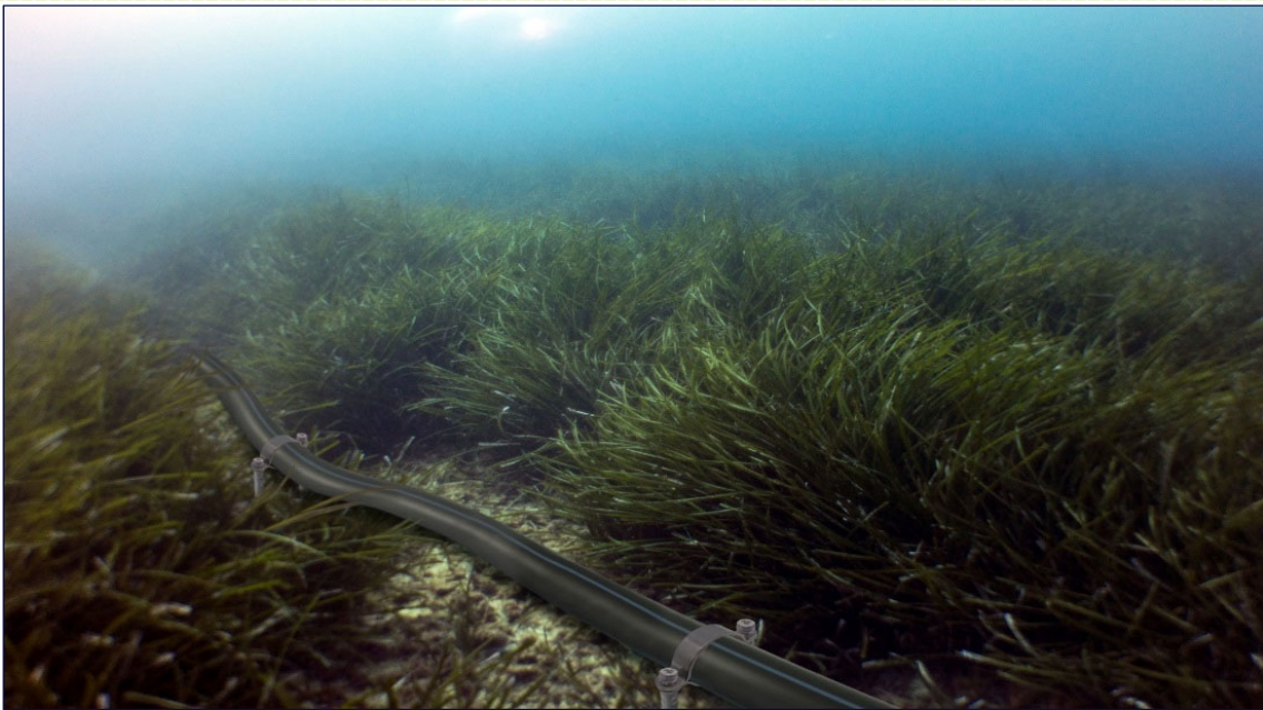
Figure 50. Illustration d'une conduite ancrée sur le fond
