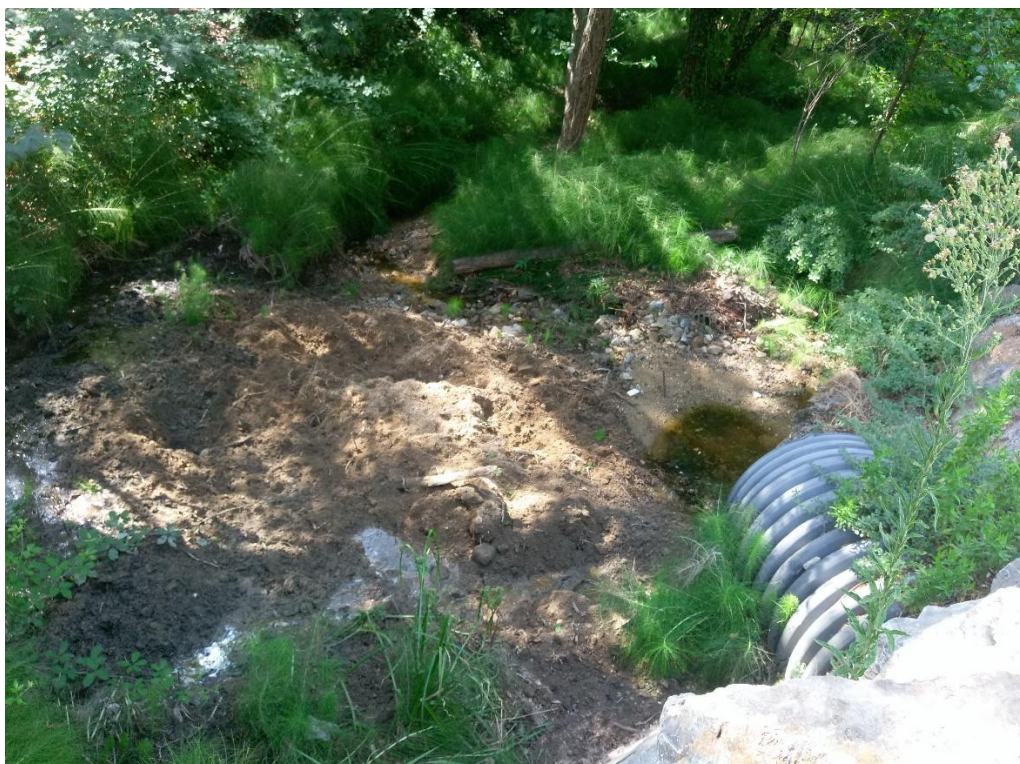
Figure 3 – Photo de l'aval de l'ouvrage busé actuel
