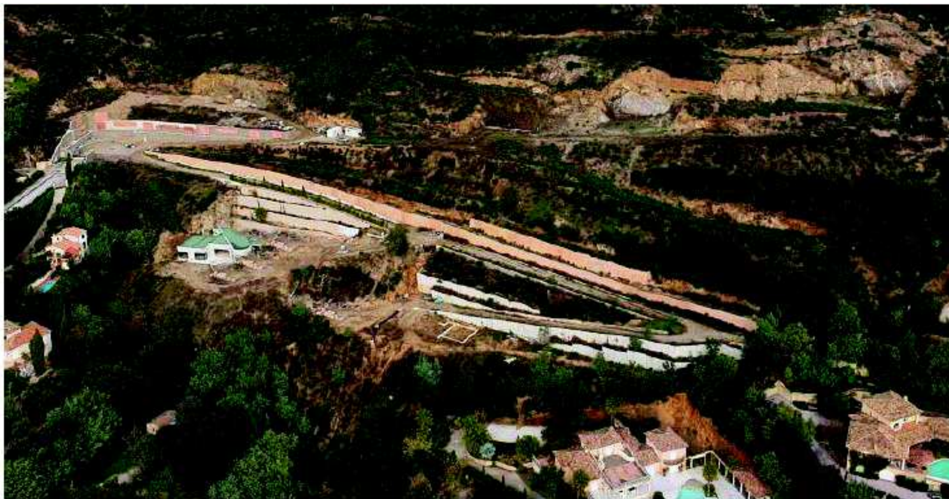
Figure 84 – Photographie du site d'étude (septembre 2020 – G&A architecte)
