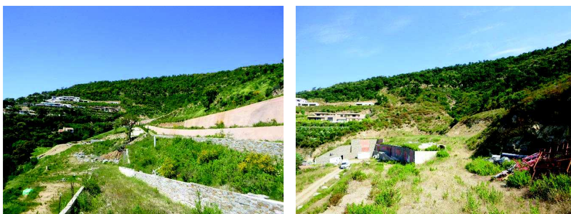
Figure 120 – Aperçus des terrassements et aménagements effectués (P.AUDA)
