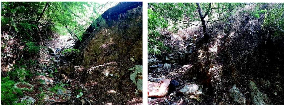
Figure 11 : Instabilité de berge sur la Suane : déstructuration de la berge, affouillement en pied et ravinement
