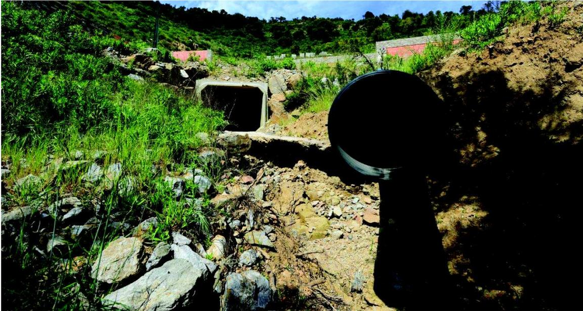
**Figure 15 : Zone affouillée en sortie du cadre et de la buse de rejet des EP**
