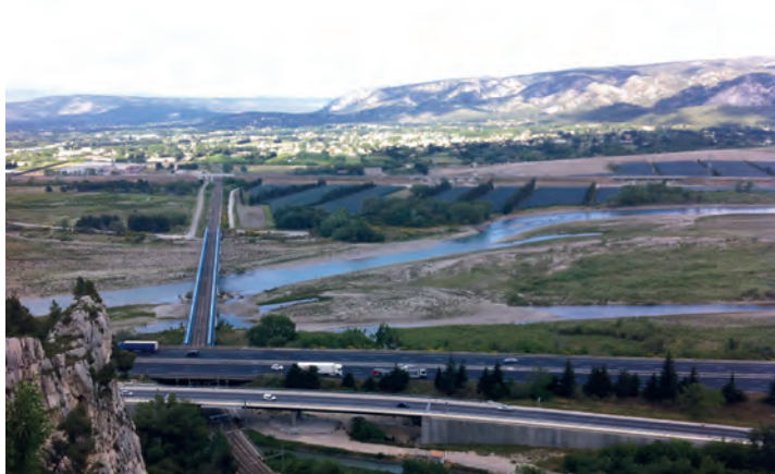
⌚ Cumul d'infrastructures linéaires en vallée de la Durance
