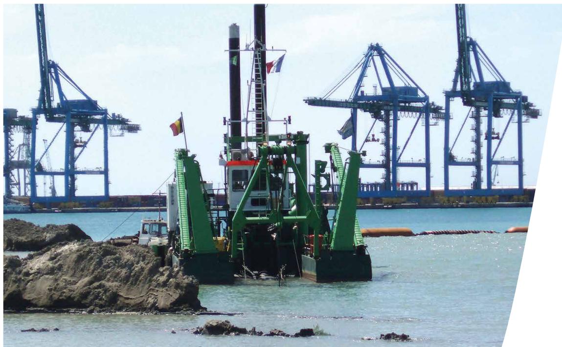
Travaux portuaires (© DDTM13)
