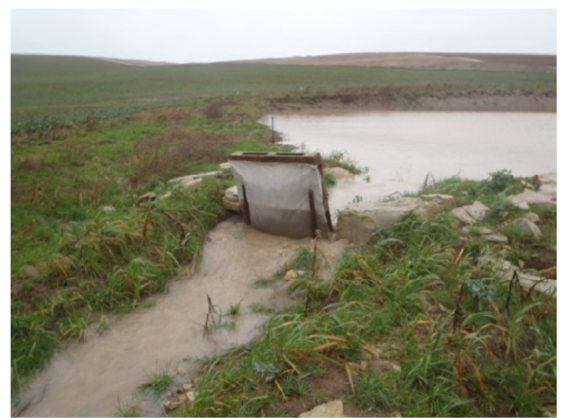
⊗ Débordement avant traitement des eaux, lié au sous dimensionnement du bassin (Source : Onema)
