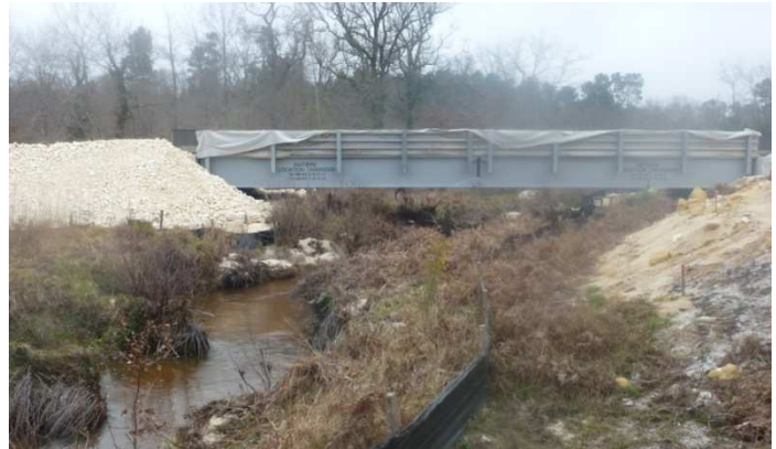
Ouvrage de franchissement provisoire sans assise en lit mineur. LGV Sud Europe Atlantique (Source : Onema)
