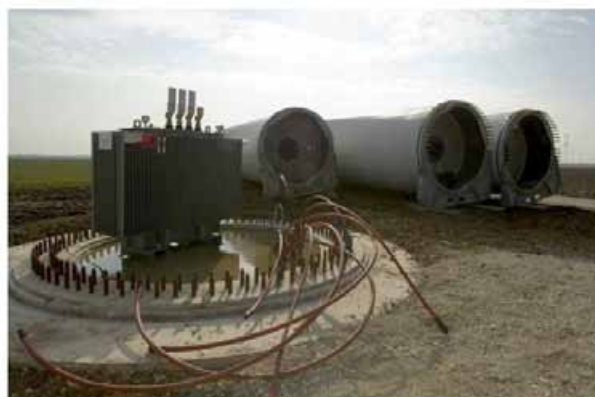
Chantier d'un parc éolien
