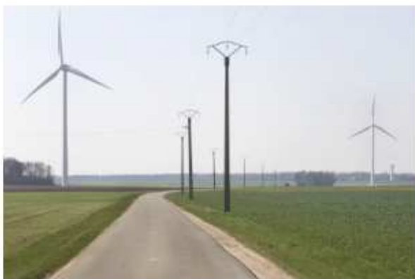
Parc éolien et lignes électriques
