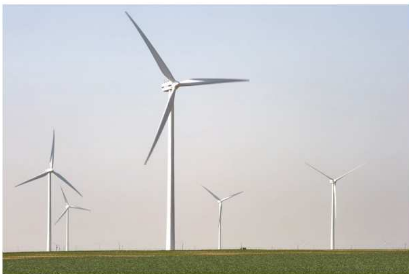
Parc éolien dans la Beauce
