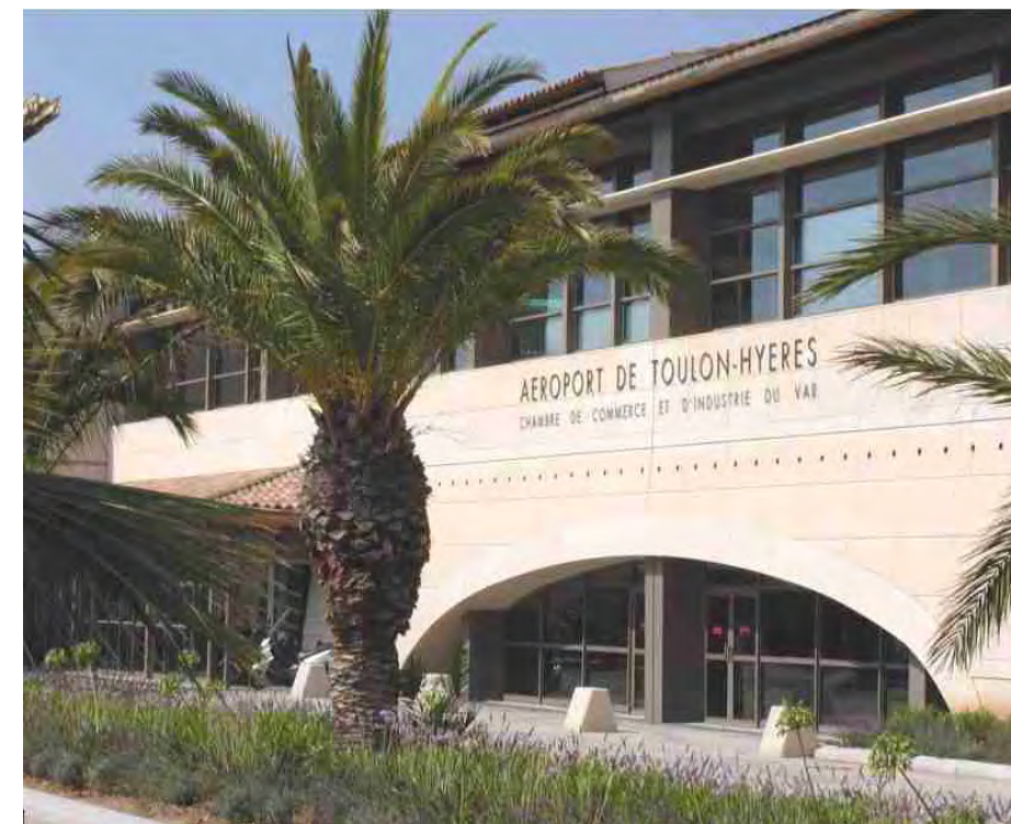
En zone est : les installations civiles
