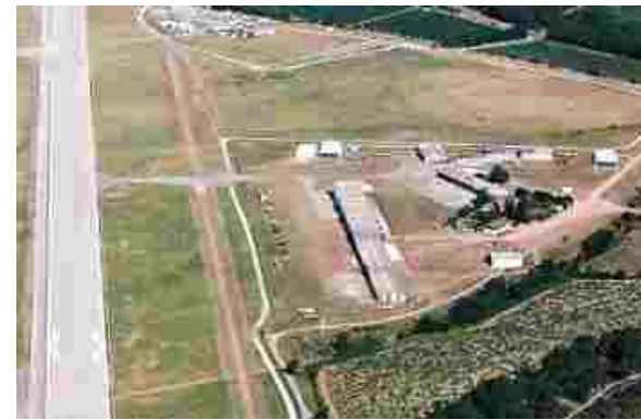
En zone nord : les installations civiles
