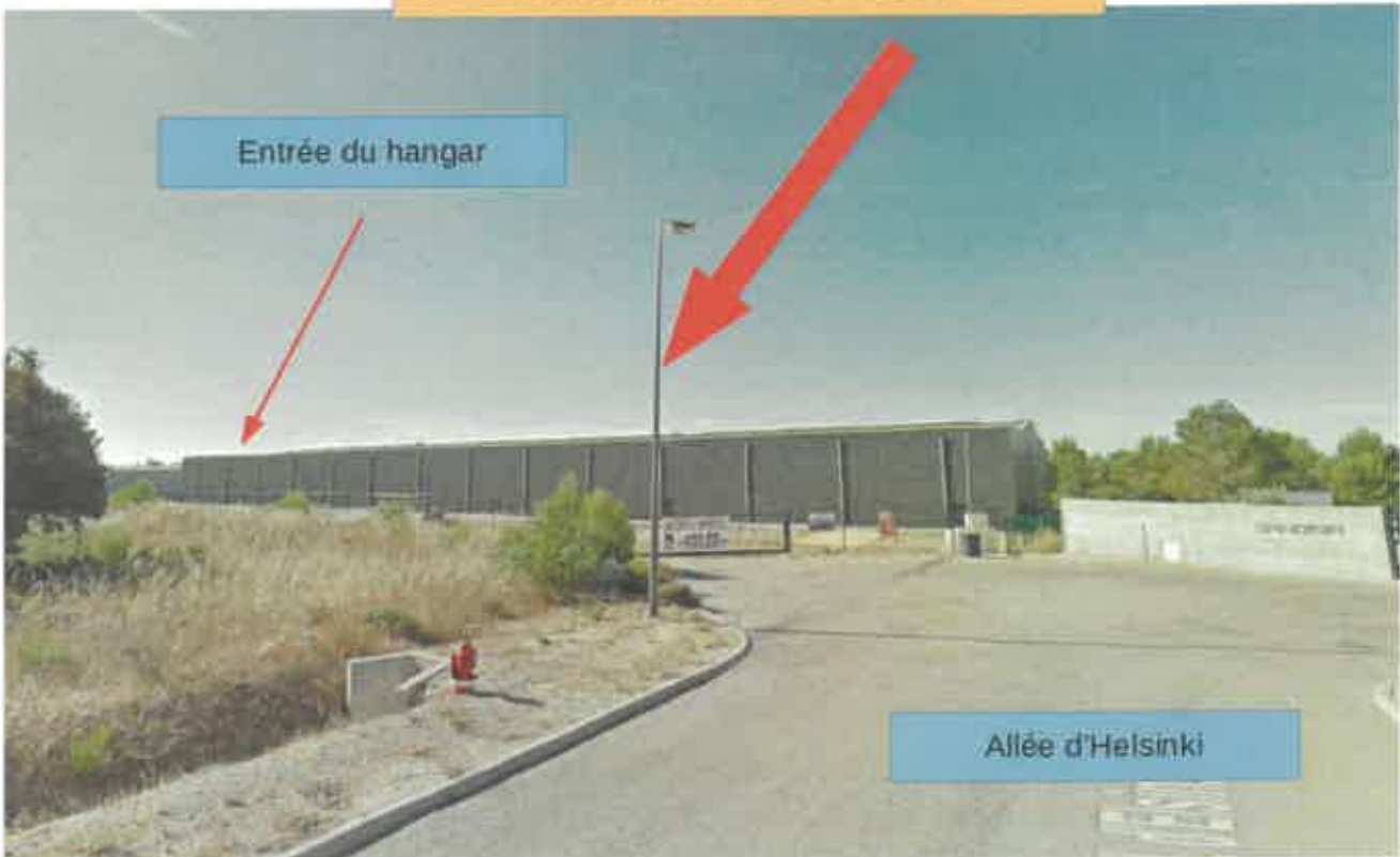
HANGAR DE MISE SOUS PLI
