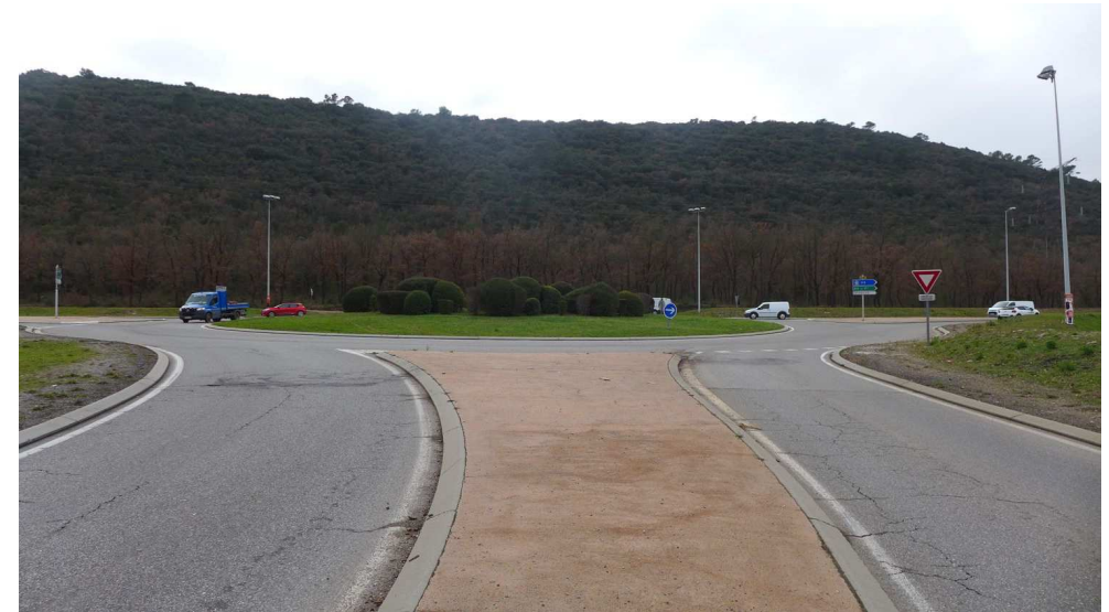
Giratoire d'accès à la ZA - Depuis la ZA
