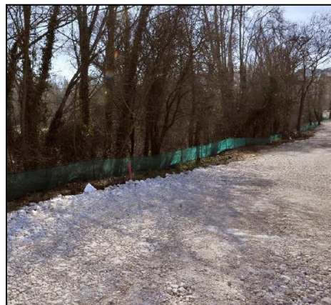
Exemple d'un dispositif anti-franchissement amphibiens avec filet en mailles fines mis en place sur un chantier à Aix-en-Provence par ECOTONIA
