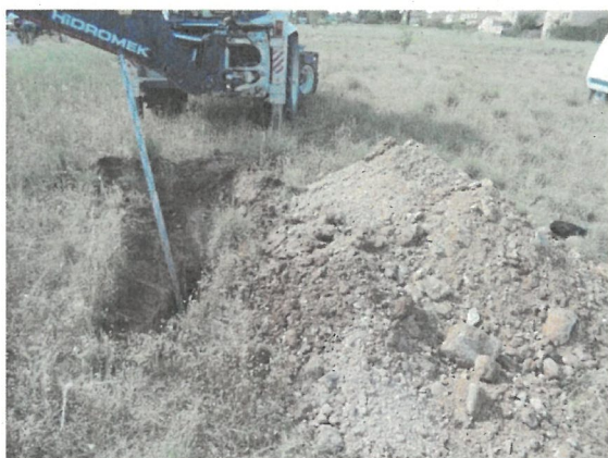
Exemple d'un sondage à la pelle
