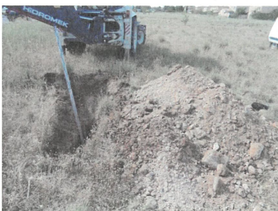
Exemple d'un sondage à la pelle
